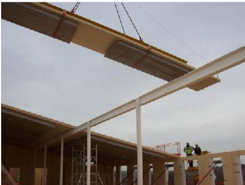
Kuva 4. CLT-kattoelementti, johon on kiinnitetty kaksi betonielementtiä passiivista lämmöntalteenottoa varten (Milner Associates)
