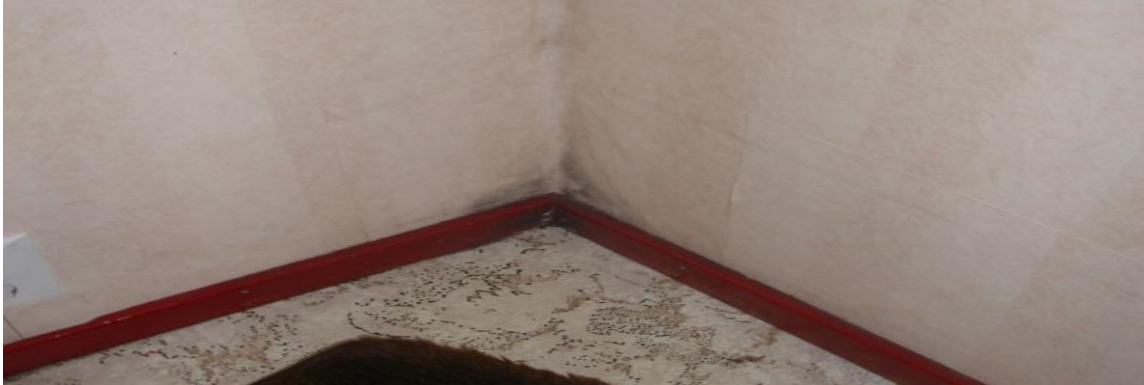
KUVA 3. Huonosti toimiva ilmanvaihto voi jopa aiheuttaa homekasvustoa sisäpinnoilla (5)
