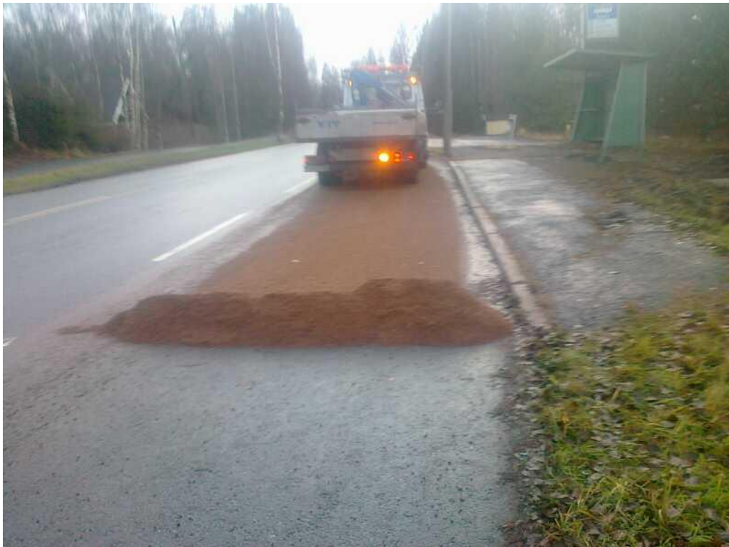
Kuva 5. Epäonnistunut hiekoitus (Kuva: Saku Syvälä 2012)
