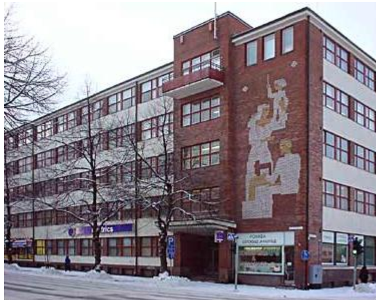
Kuva 1. LSK:n pääkonttori Lahden Vesijärvenkadulla (LSK Electrics Oy)
