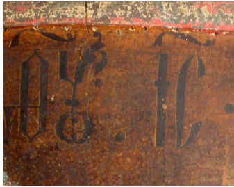
Kuvio 16. Päällemaalauksen alta paljastuneet, osittain sen alta kuultaneet, alkuperäiset kyrilliset kirjaimin maalatut tekstit.
