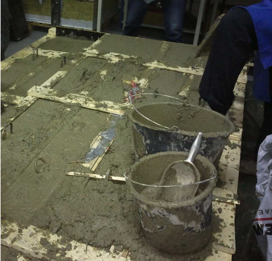
KUVA 14 Palkkien valaminen
