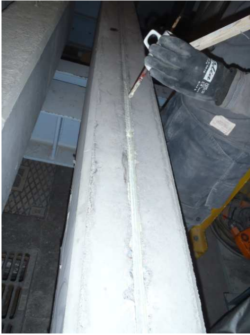
Kuva 15 Uran primerointia. Palkki on käännetty ylösalaisin
