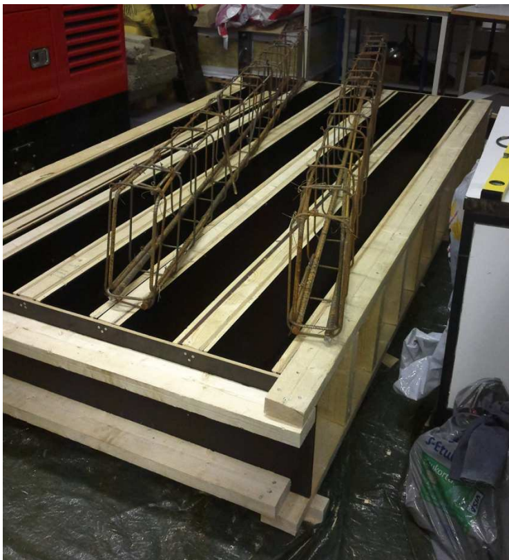
KUVA 9 Valmiit raudoitteet ja muotti.
