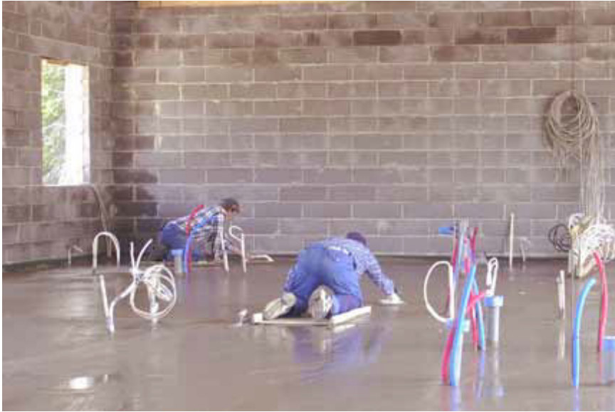
KUVA 6. Betonilaatan hiertoa käsin (Palolahti 2011, 27)
