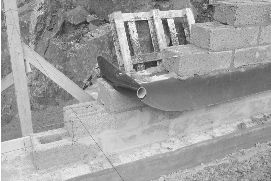
KUVA 5. Harkkorakenteiseen kellarinseinään asennetaan bitumikermikaista (RT 81-10791. 2003, 7)
