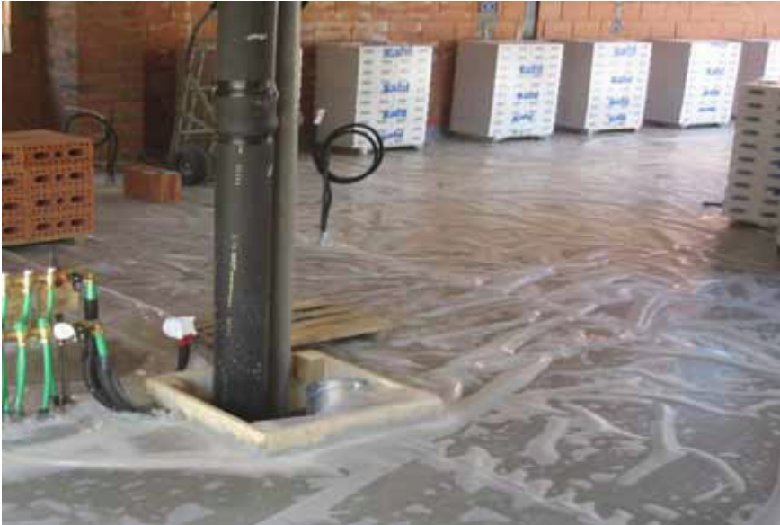
KUVA 7. Betonipinnan päälle levitetään muovikalvo, mikä estää betonin liian nopean kuivumisen (Palolahti 2011, 28)
