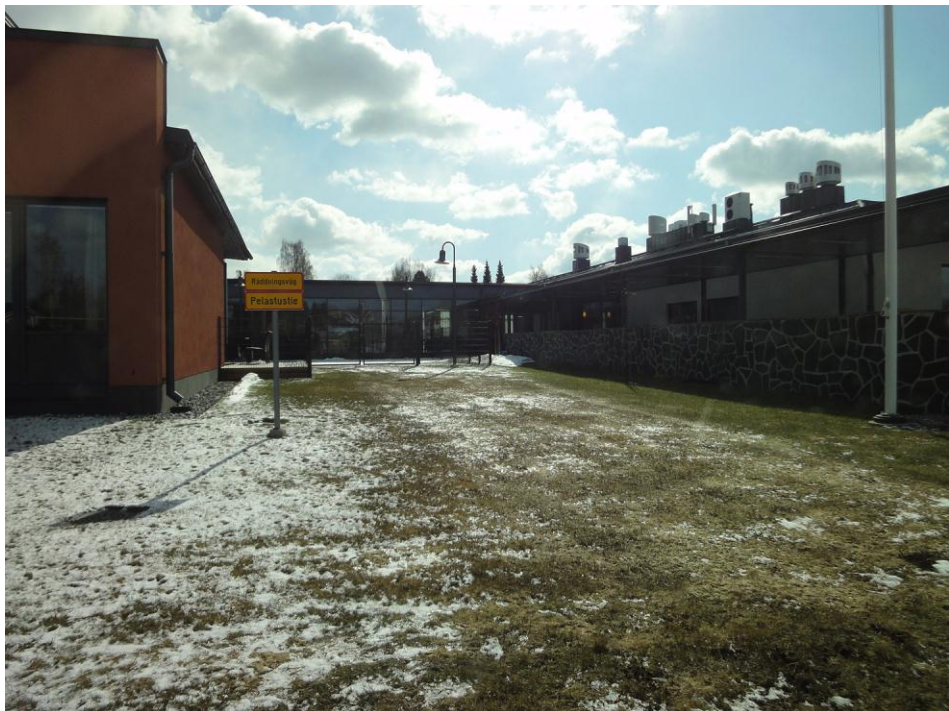
Kuva 20. Vahvistettu nurmikko erottuu huonon kasvun vuoksi muusta nurmialueesta. Tällä pelastustiellä ei ole ollut talvikunnossapitoa. Kuva on otettu nurmialueen reunasta, koko kantavana nurmikkona tehty pelastustieosuus on kuvassa.
