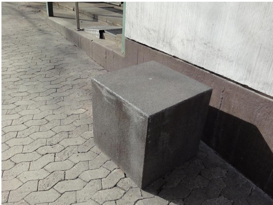
Kuva 27. Jalankulkijoiden suojaksi tuotu graniittikuutio Helsingissä, Itä-Pasilassa.
