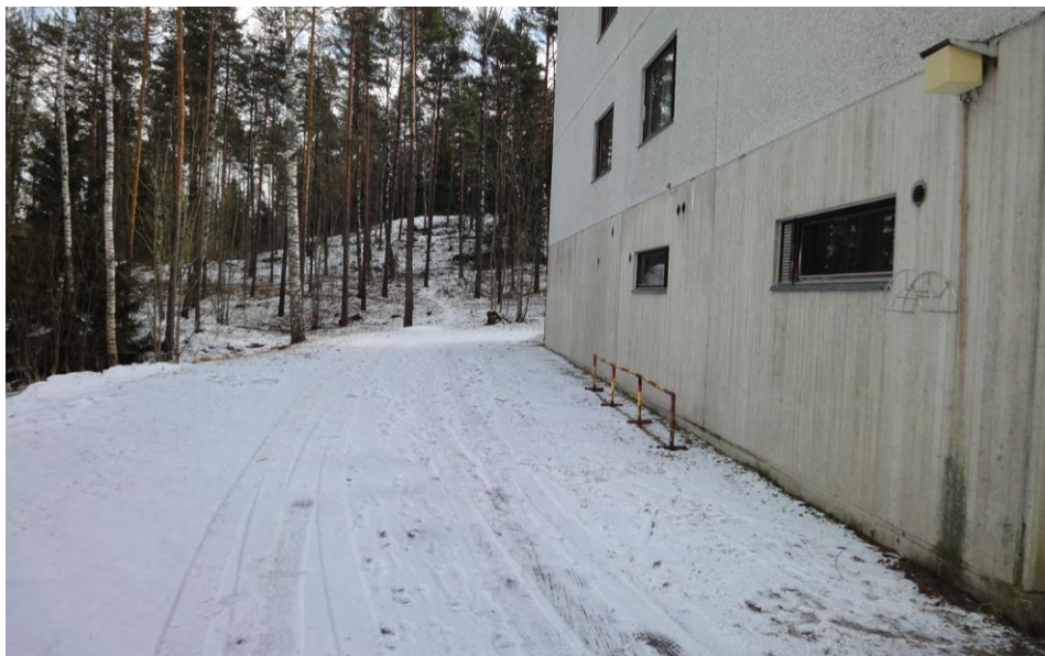
Kuva 21. Kerrostalon päädyn pelastustie on vahvistettua nurmea. Alueen talvikunnossapidosta on huolehdittu auraamalla lumet pois. Tiellä ei ole normaalisti autoliikennettä, renkaanjäljet ovat oman testimme tuotosta.
