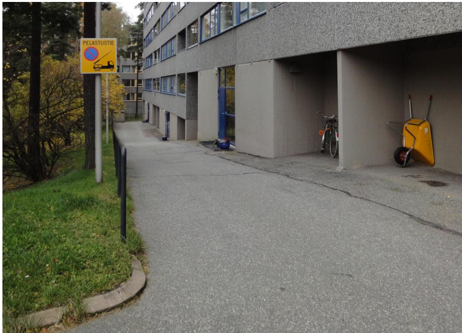
Kuva 7. Vanhassa kohteessa pelastustiemerkki ei takaa alueen toimivuutta pelastustienä.
