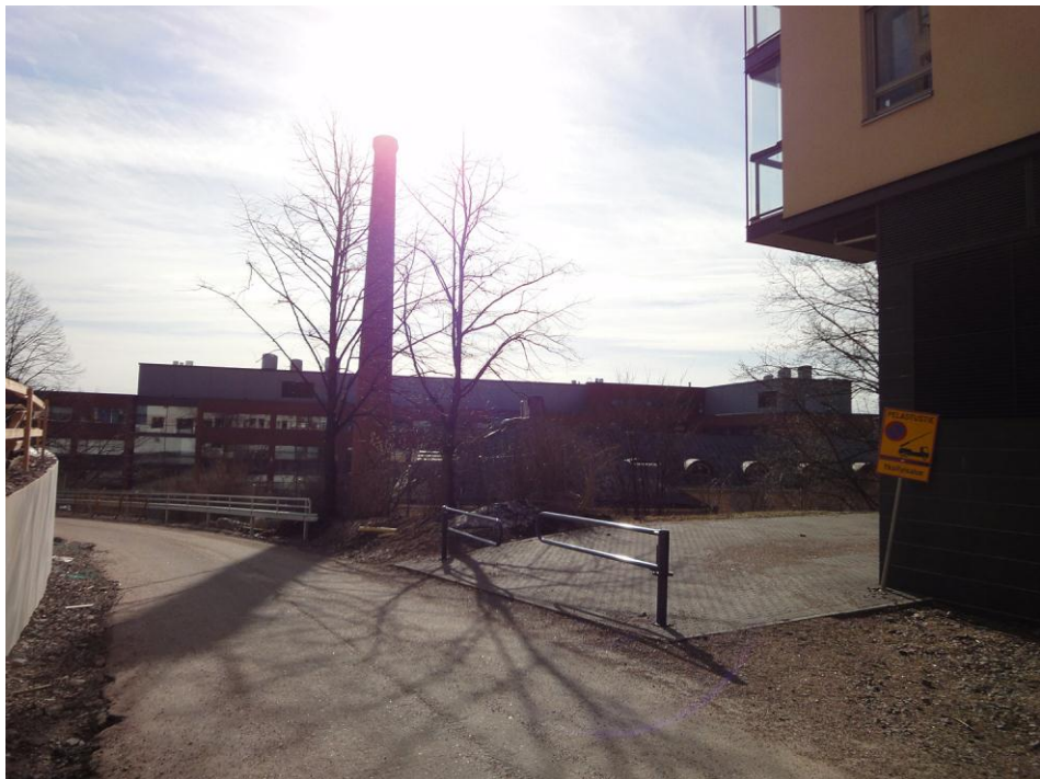
Kuva 29. Ajoestepuomit on sijoitettu väärin, näin ne estävät nostolava-auton kääntymisen pelastustielle.
