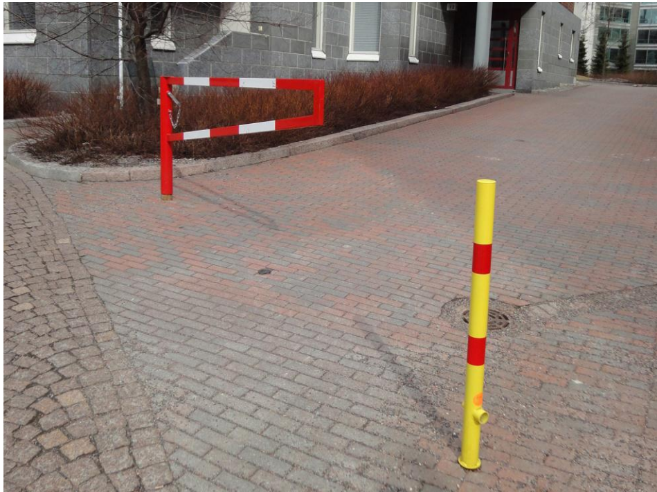
Kuva 28. Erilaisia ajoesteitä Helsingissä. Talvella ne saattavat heikentää talvikunnossapitoa tai ne saattavat jäättyä. Kuvan ajoesteet aukeavat kolmioavaimella.
