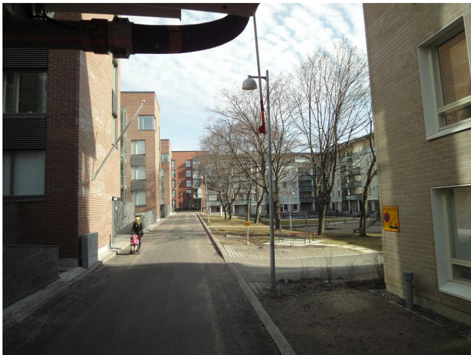
Kuva 5. Oikealla oleva pelastustie toimi, kunnes vastakkaiselle tontille rakennettiin rakennus kiinni tontin rajaan. Pelastustien toimivuutta edesautettiin lisäämällä kääntötilaa nurmikivellä vahvistetun kulman avulla. Silti kohteeseen pääsee tästä suunnasta vain peruuttamalla.
