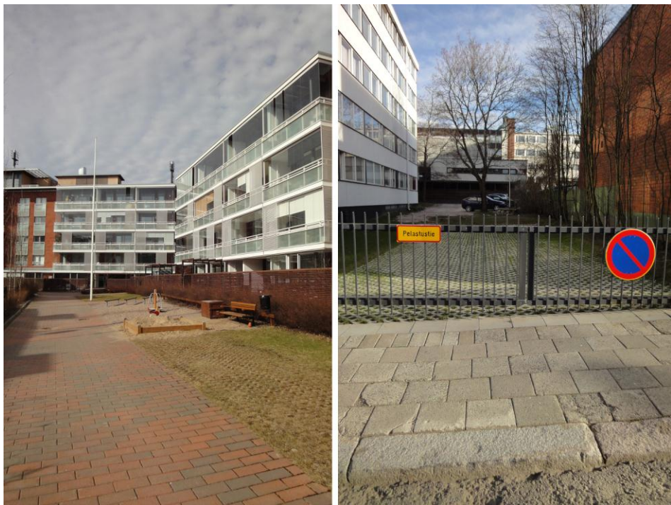
Kuva 18. Ahtaisiin tiloihin on saatu lisää vihreyttä ja imeyttävää pinta-alaa nurmikiven avulla. Molemmissa kohteissa nurmikivellä päällystetyt alueet ovat nostoalueita.
