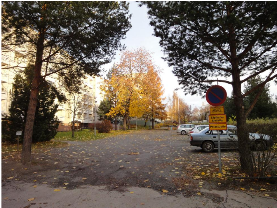
Kuva 16. Pelastustienä ja nostoalueena toimii kivituhkalla päällystetty kenttä.
