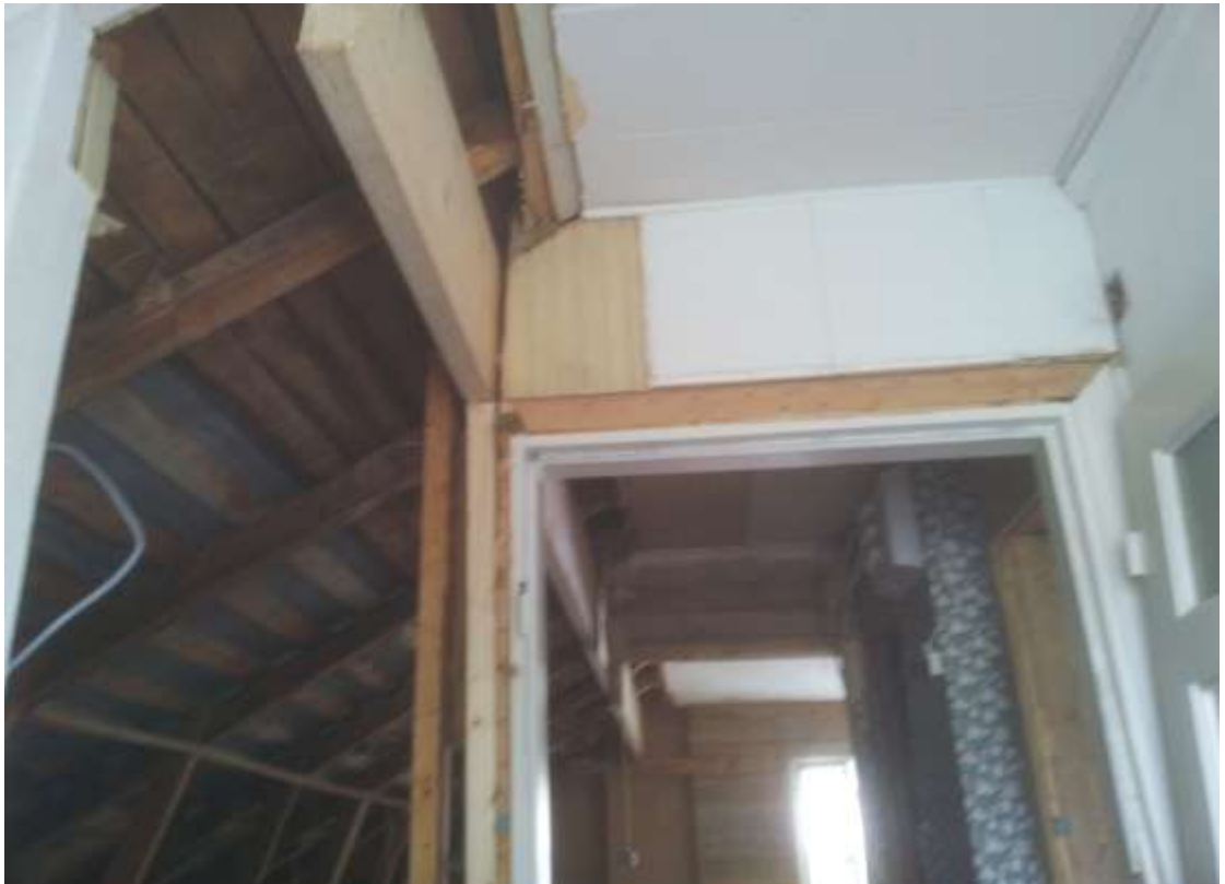
Kuva 9. Ensimmäinen palkki paikallaan. Kuva: Juha Honkala
