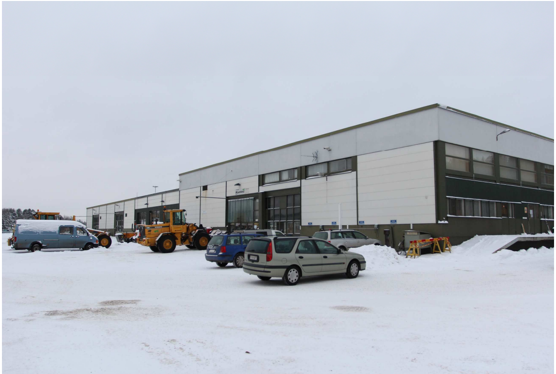
Kuva 1. Turun Seudun Kuntatekniikka Oy:n korjaamo.
