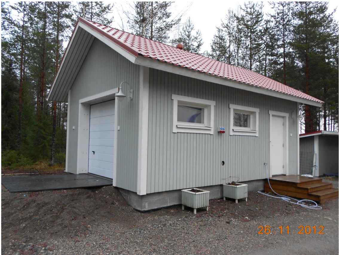
Kuva 1. Mahlan jalostuksessa käytetty puhdastilarakennus. (Kuva: Hannu Piironen.)
