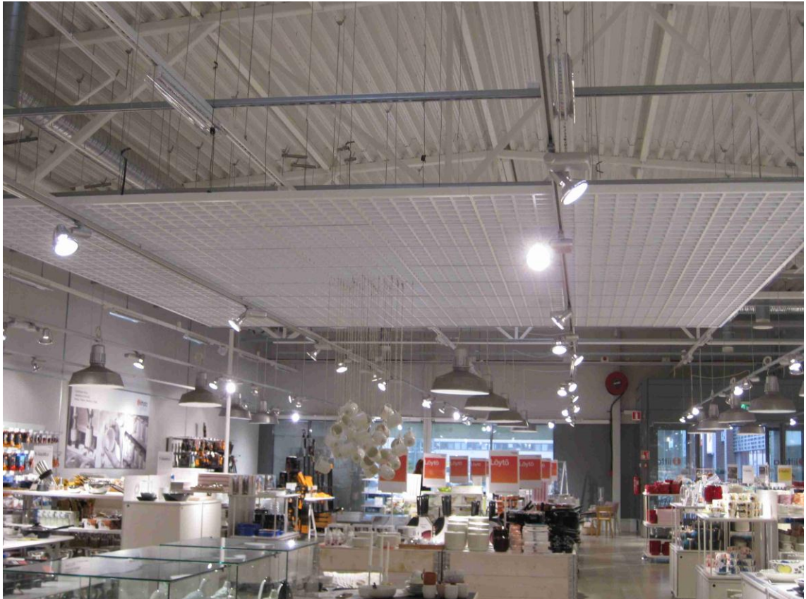
Kuva 12. Kuvassa näkyy tilan alas laskettu katto.
