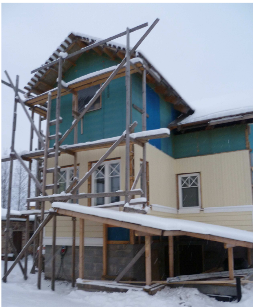
Kuva 8. Talon sisäpiha. Uusi rakennusosa vielä keskeneräinen.
