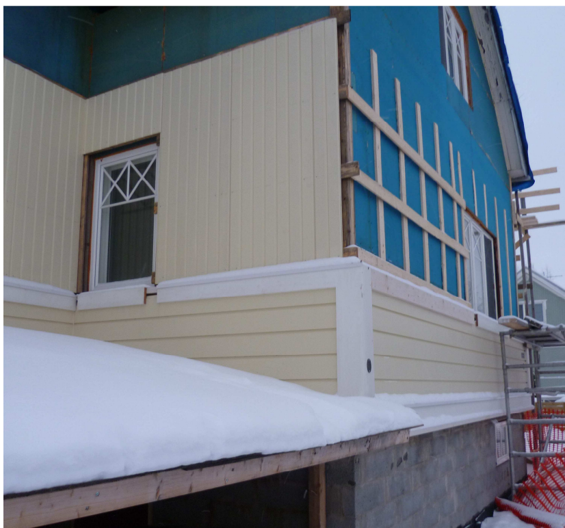
Kuva 5. Uusi julkisivu ja rakenteet.
