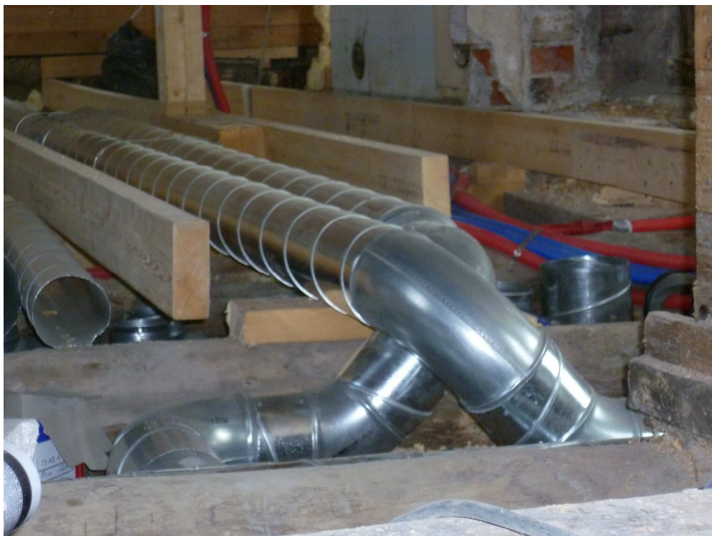
Kuva 4. Alemman välipohjan päälle asennetut lisä kannattimet, iv- ja vesiputket
