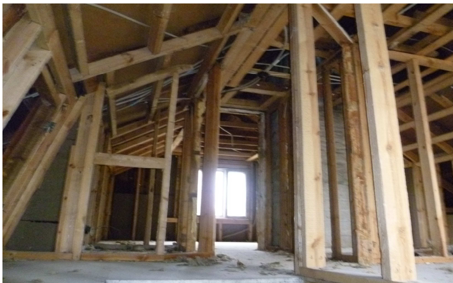
Kuva 2. Yläkerrasta kaikki seinäpinnat purettuna ja runko jäljellä.
