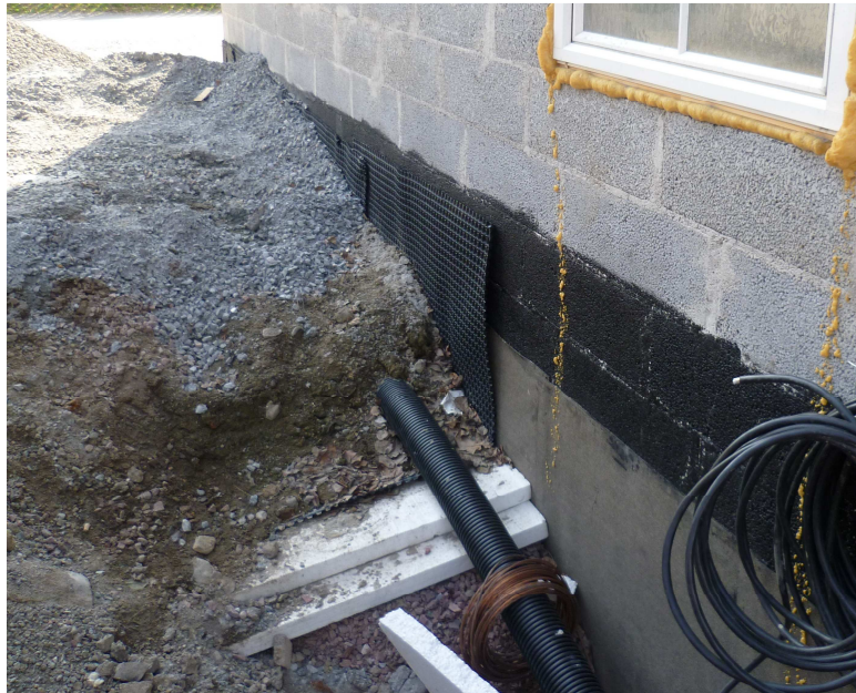
Kuva 3. Kellarin seinän vedeneristys.
