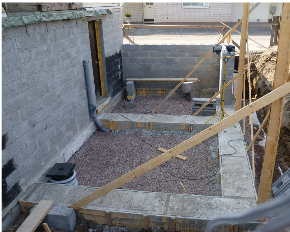
Kuva 7. Uuden rakennusosion anturat valettuna ja terassiosion harkkoseinän muuraaminen aloitettu. Kuvassa myös talon viemärit.
