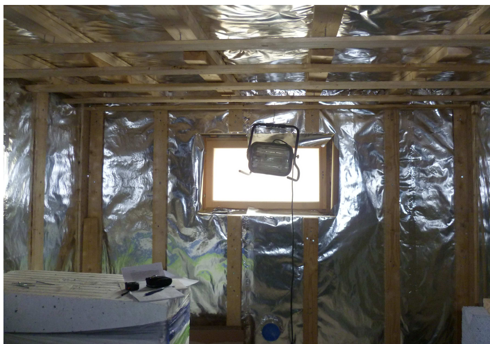
Kuva 6. Saunan seiniin ja kattoon asennettiin alumiinipintainen ilmansulkupaperi. Kattopinta oikaistiin ristiinkoolauksella ja ruuveja säätämällä.
