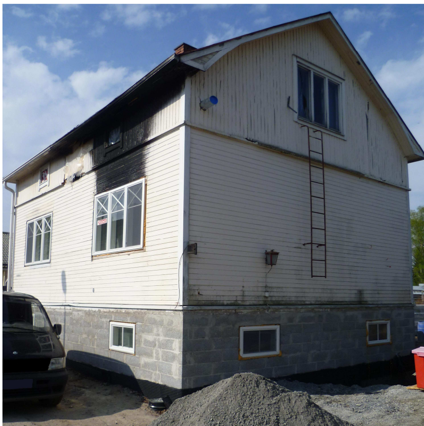
Kuva 1. Talon itäinen kulma. Palovaurio vielä näkyvissä vanhassa julkisivussa. Kellarin seinät ja ikkunat uusittu.
