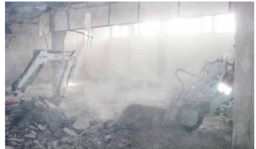
Kuva 2. Raskas purkutyö tuottaa ilmaan runsaasti pölyä – peruskorjauskohteissa rajapinnan tiiviys ja työmaan alipaineistus on tärkeää.
