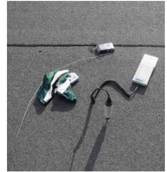
Kuva 2. Liikuntahallin kattorakenteiden kosteusmittaus.
