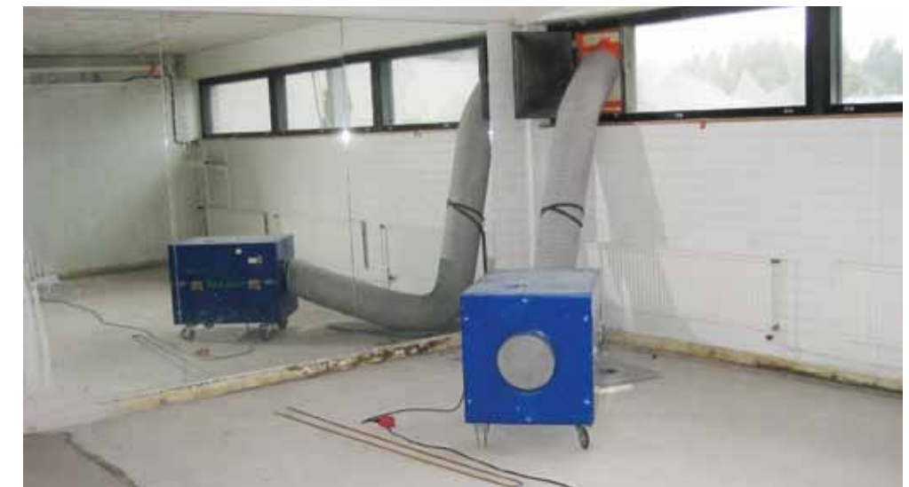
Kuva 4. Puhtaudenhallinnalla työskentelyolosuhteet työmaalla paranevat.
