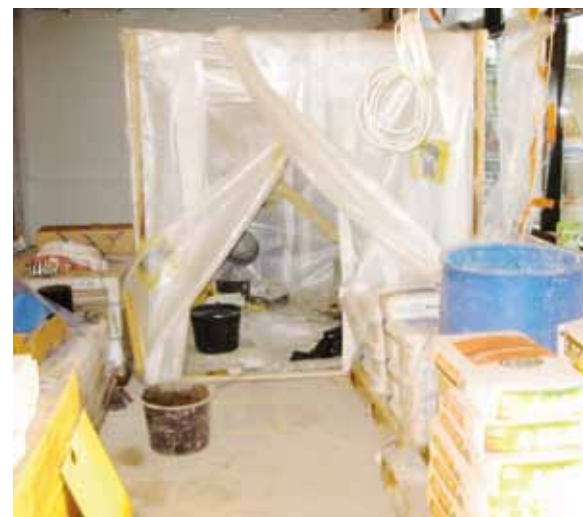
Kuva 3. Osastoitus ja alipaineistettu sekoituspiste estää pölyn leviämisen työmaalle.
