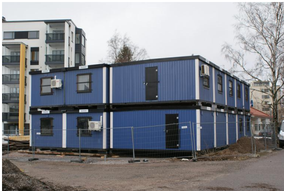
Kuva 1. Työmaatilaryhmä, As Oy järvenpään Saundi. [4].
