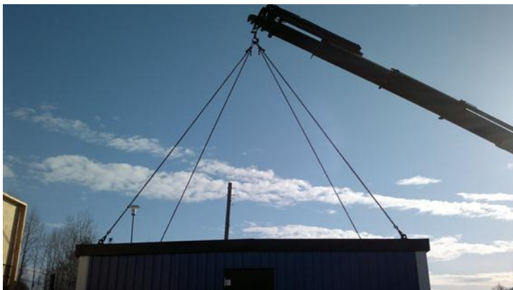
Kuva 6. Tilaelementin nosto. [3].
