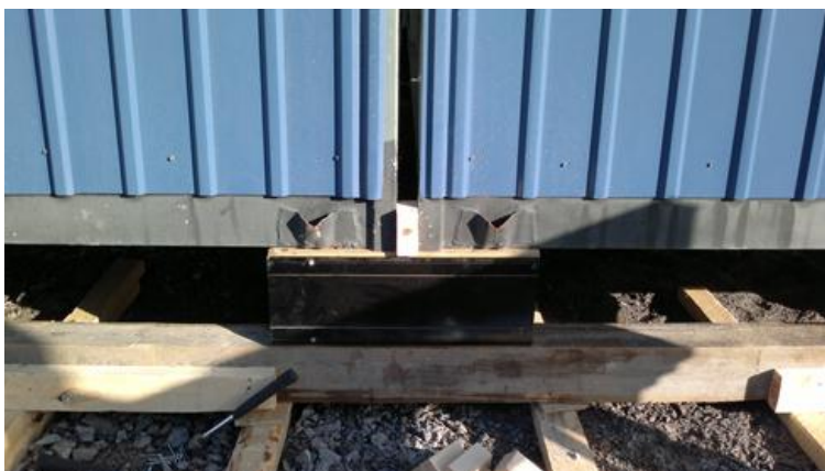
Kuva 4. Tilaelementtien liittyminen toisiinsa. [3].
