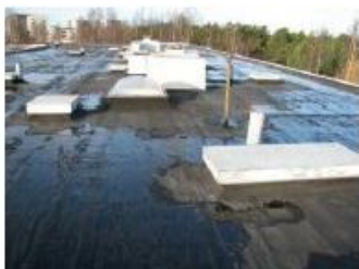
Läpivientejä on paljon.
