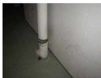
Viemärit ovat muoviputkea
