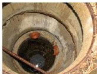
Salaojakaivo ja tuliputket
