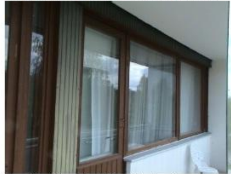
Kuva 23. Alkuperäiset ikkunoiden ja ovien maalipinnat ovat kunnossa
