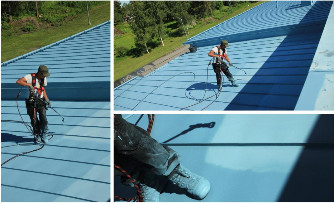
KUVA 13. Vanhan peltikaton maalausta (9)
