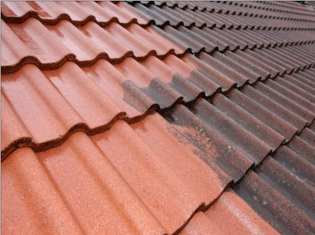
KUVA 11. Osittain puhdistettu tiilikatto (9)
