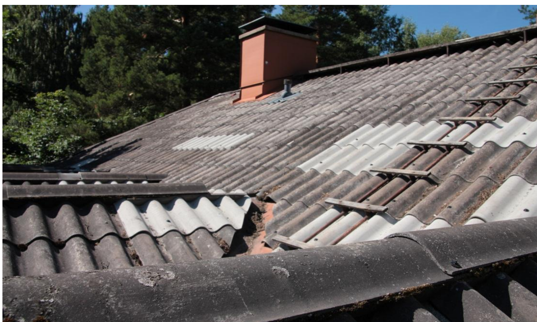
KUVA 6. Uusia mineriitti levyjä vaihdettu huonojen tilalle (9)
