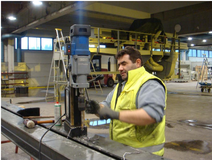
Kuva 8 Laitetoimittajan asentaja Alex Mainecken poraa reikiä
