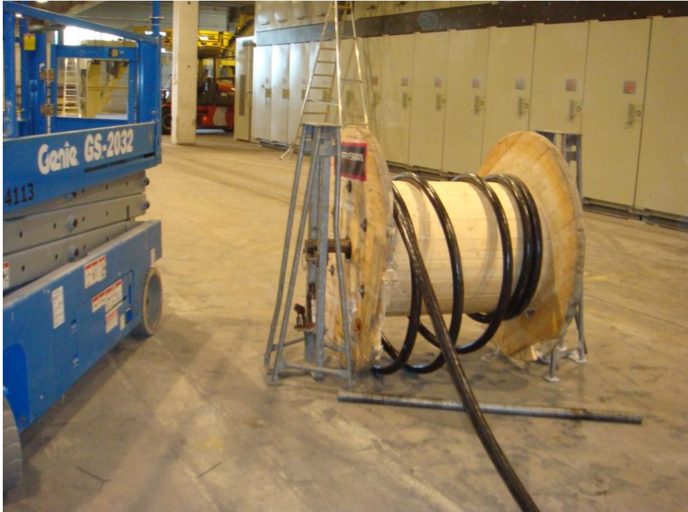
Kuva 7 Uusien sähkölinjojen vetoa
