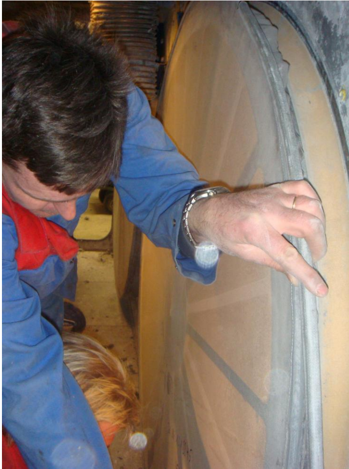
Kuva 10 Pölynpoiston asennusta Empowerin asentajien toimesta
