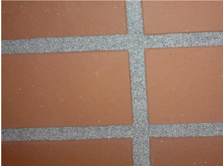
Kuva 4. Kahden elementin välinen elastinen sauma [4].
