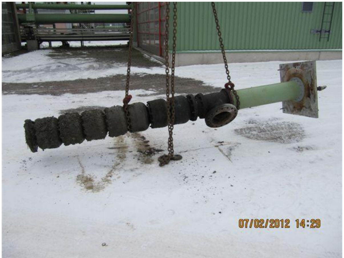
KUVIO 14. Pumppu YGA-33 ylösnostettuna huoltoa varten
