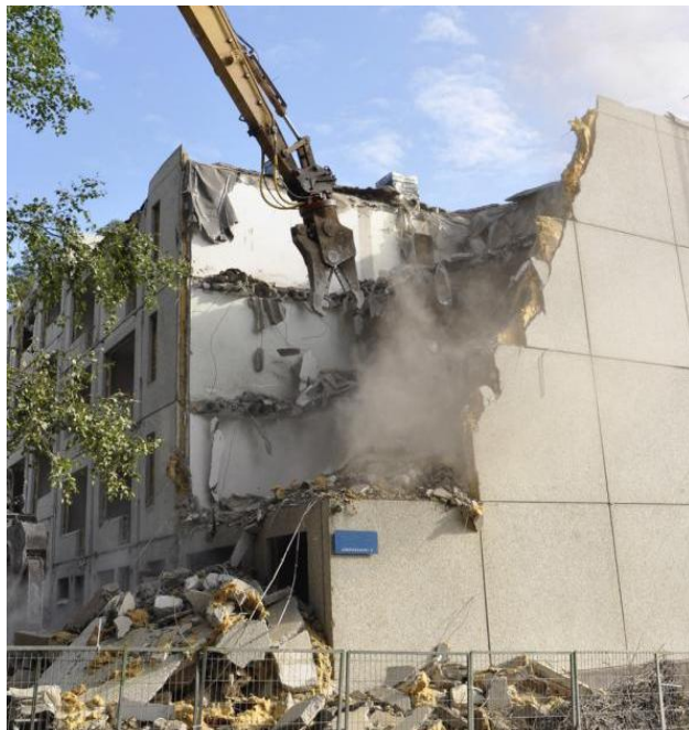
Kuva 3. Elementtitalon purku. (Nollaenergiaprojektin www-sivut.)
