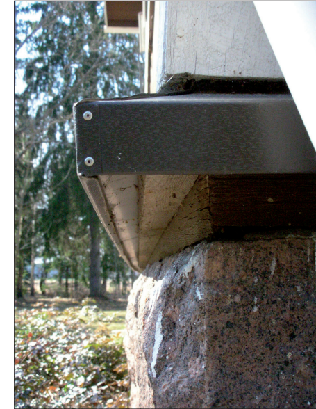
KUVA Kivijalan nurkka.
