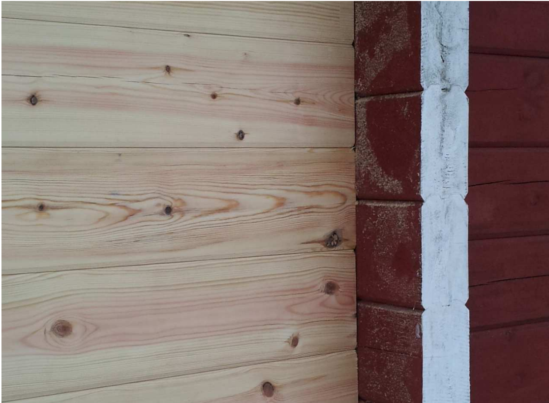
KUVA 2. Uuden ja vanhan hirsikehikon liitos
