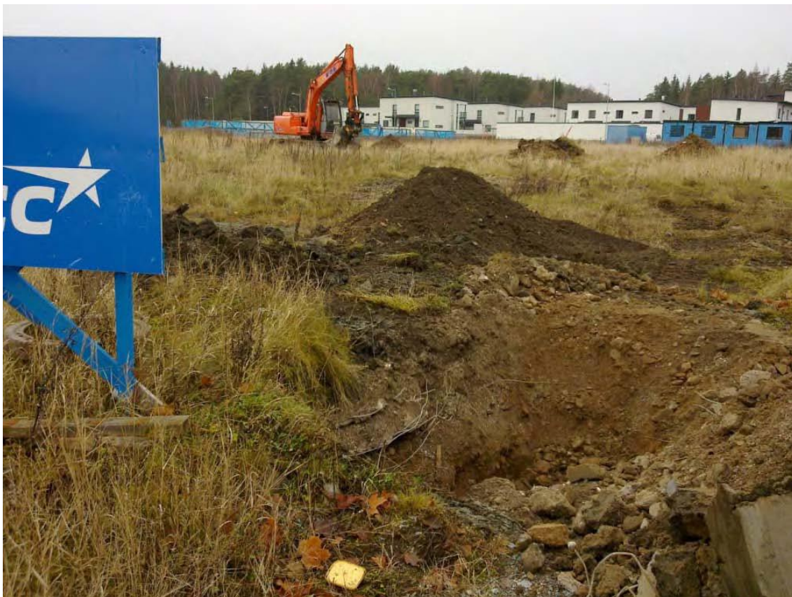
Kuva 3. Yleiskuva tutkimusalueesta ja koekuoppa KK8 (Golder Associates Oy 2009).
