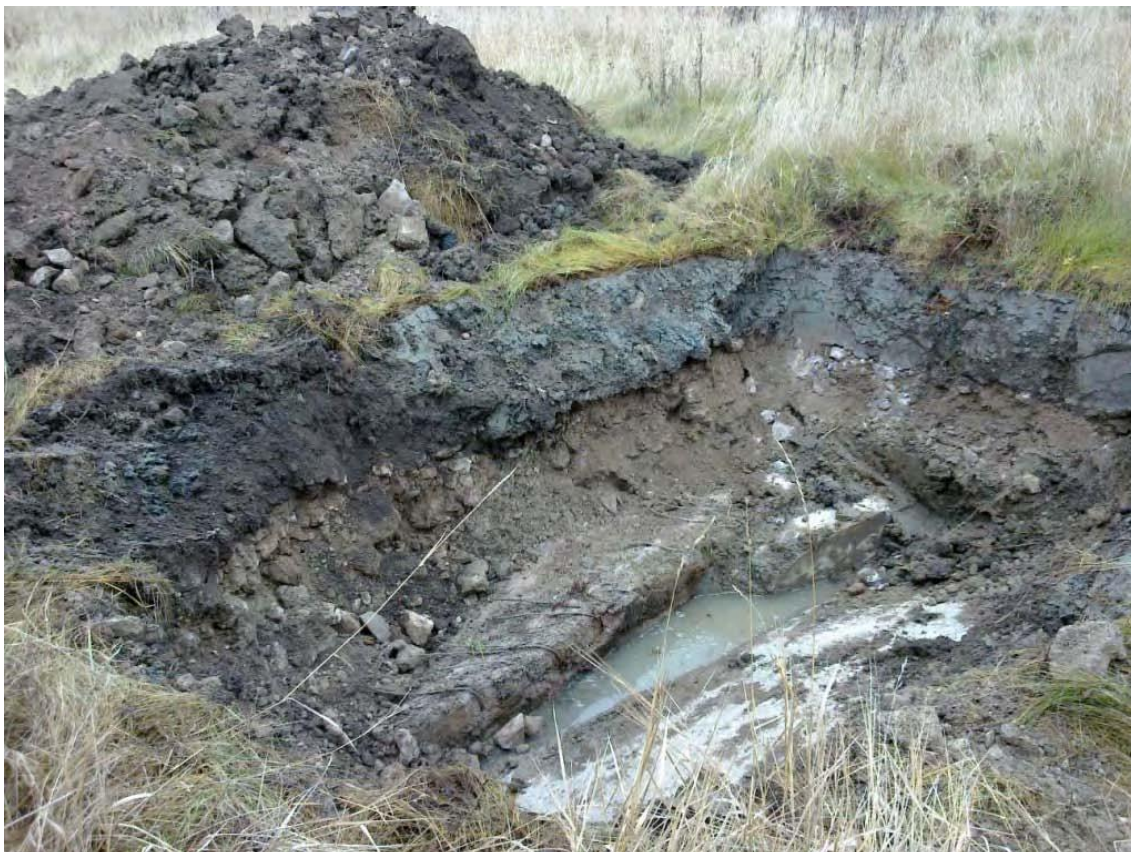
Kuva 4. Koekuopan KK3 alueella todetut rakennuksen perustukset (Golder Associates Oy 2009).
