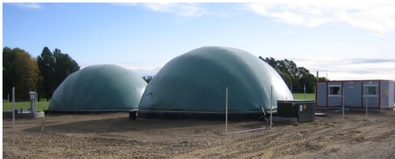
Kaasukuvut ja energiantuotantoyksikkö
