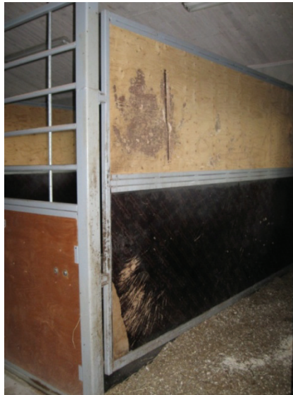
Väliseinän alaosassa näkyy kumimatto.
