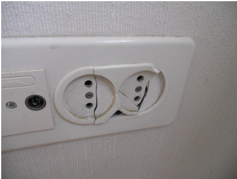
Kuva 39. Hajonneita pistorasioita.
