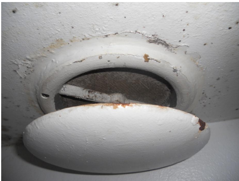
Kuva 35. Tukittu ilmanvaihtoventtiili.
