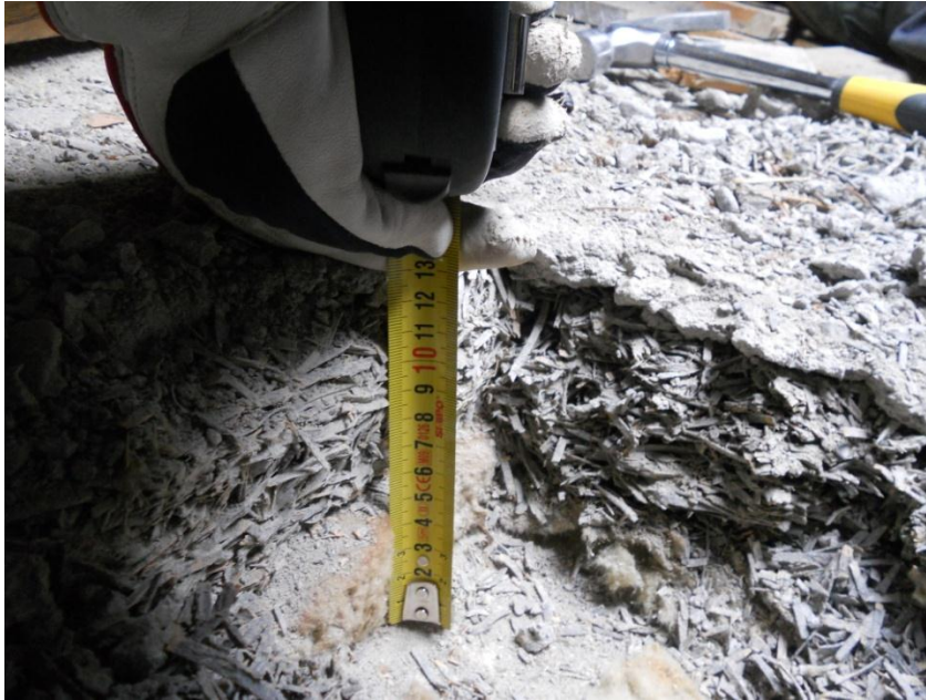
Kuva 11. Yläpohjan lämmöneristerakenne.
