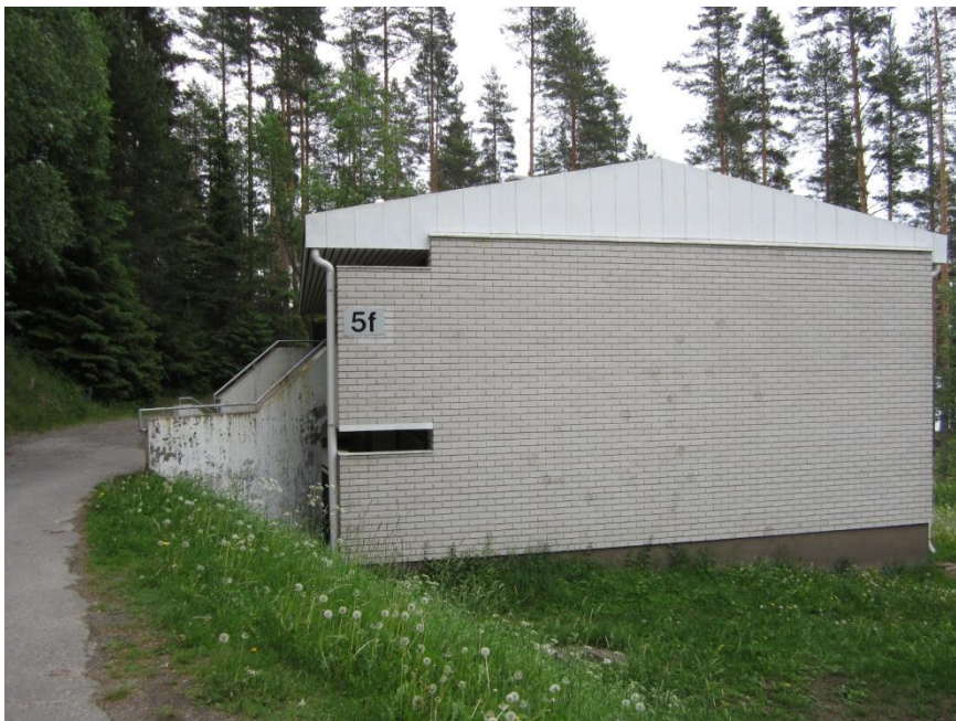
Kuva 3. Päätyseinien tiiliverhous.
