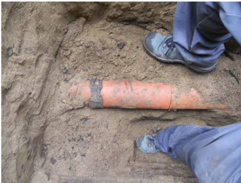
Kuva 44. Savitiiliputki takaisin paikalleen asennettuna.
