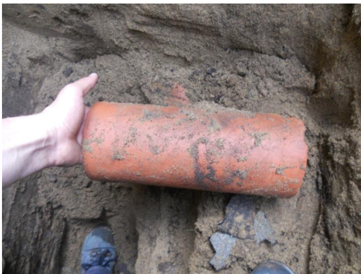
Kuva 42. Salaojana toimiva savitiiliputki.
