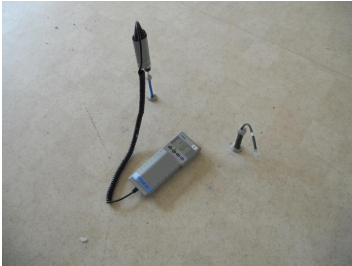
Kuva 46. Alapohjan kosteusmittaus järjestelyjä.
