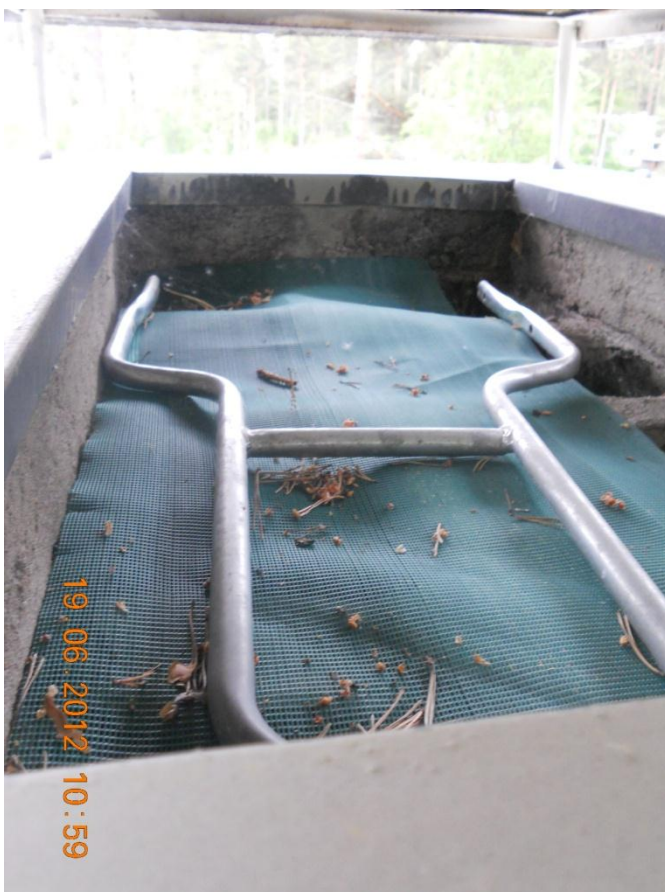
Kuva 36. Katolla ilmanvaihtohormit on peitetty verkolla.
