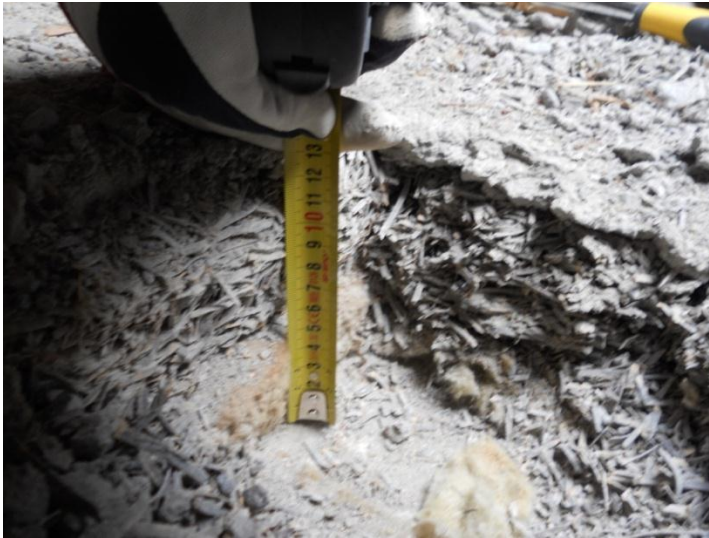
Kuva 7. Yläpohjan eristekerros.
