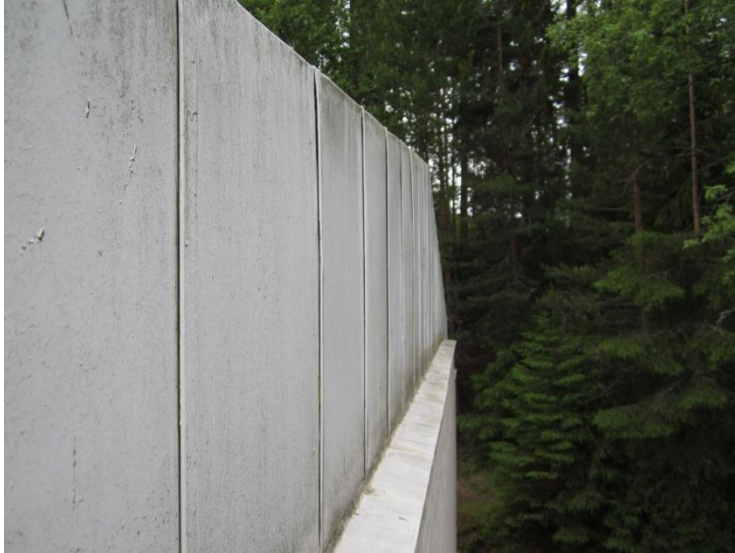
Kuva 25. Päätyseinän pellitys yläpohjan osalta.
