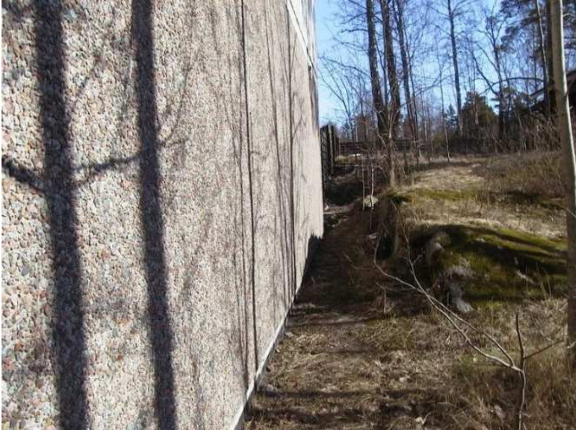
KUVA 3. Sokkeliin päin oleva kallistus (12)
