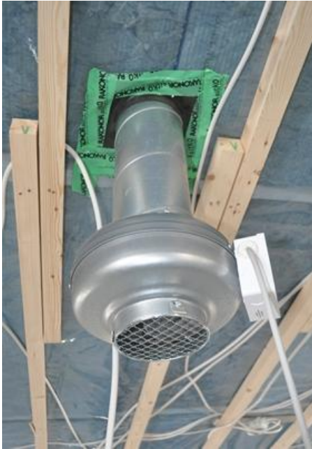
KUVA 6. Poistoilmapuhallin (14)
