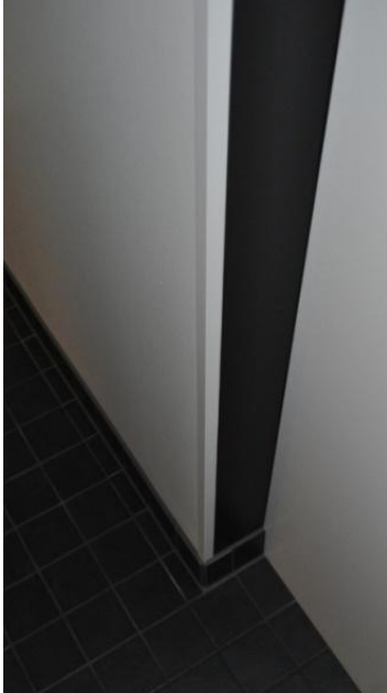
KUVA 24. Ulkokulmalista seinän ulkokulmassa (14)
