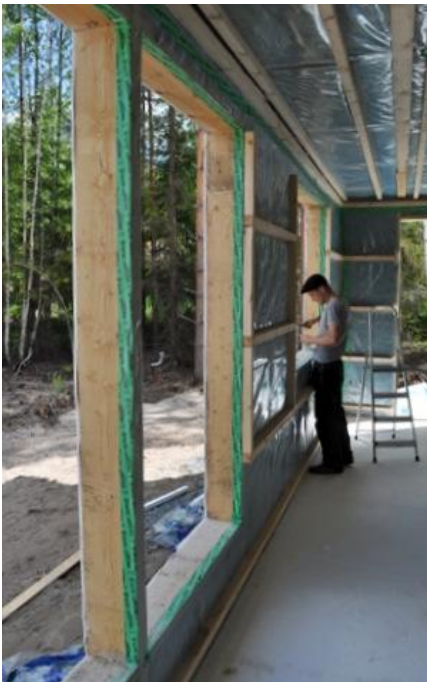
KUVA 11. Höyrynsulkumuovi taitetaan ja teipataan aukoissa runkoa vasten (14)
