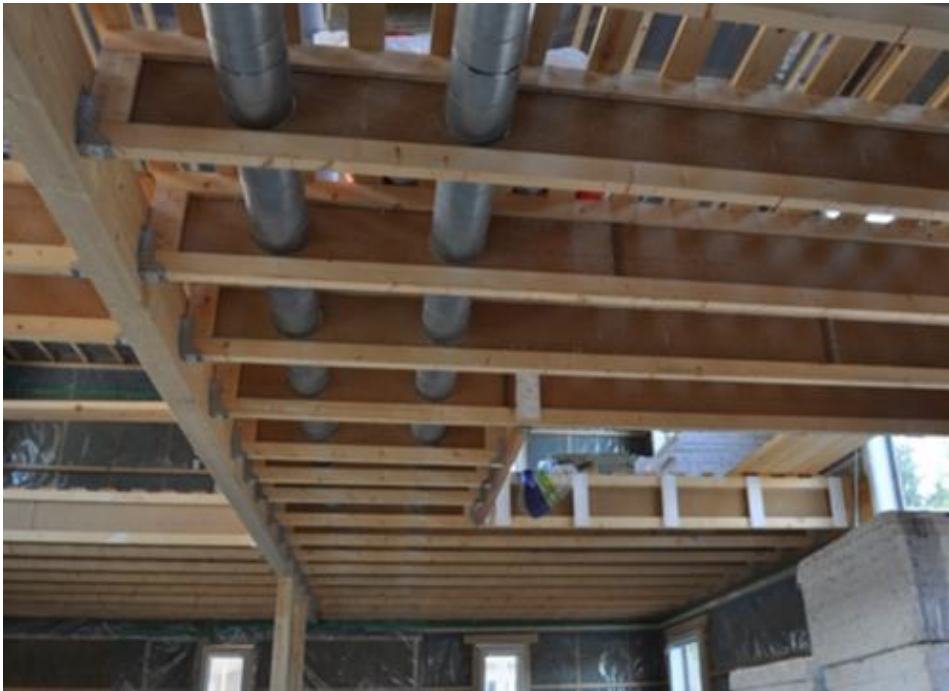
KUVA 20. Pääkanavisto palkkeihin asennettuna (14)
