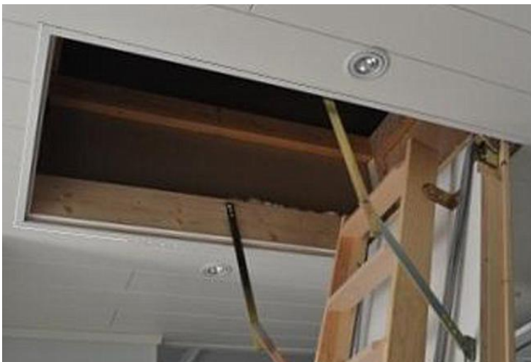
KUVA 25. Käyttöullakon aukon listoitus (14)
