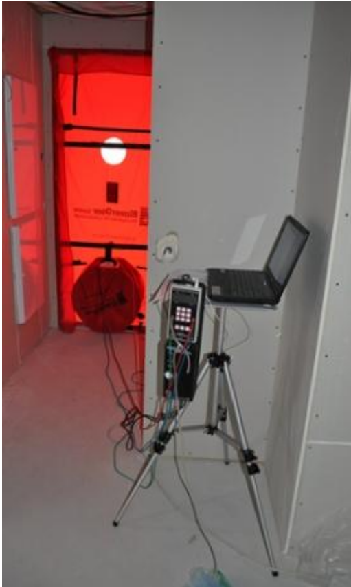
KUVA 9. Ilmatiiveysmittaus suoritetaan ulko-ovesta (14)
