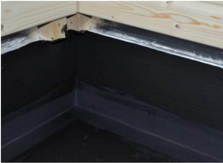
KUVA 12. Vesieristeen ja alumiinipaperin liitos (14)
