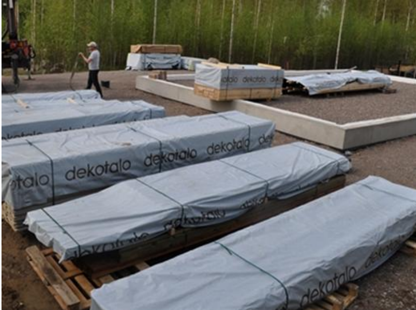
KUVA 2. Puutavaran suojauksesta työmaalla on huolehdittava (14)
