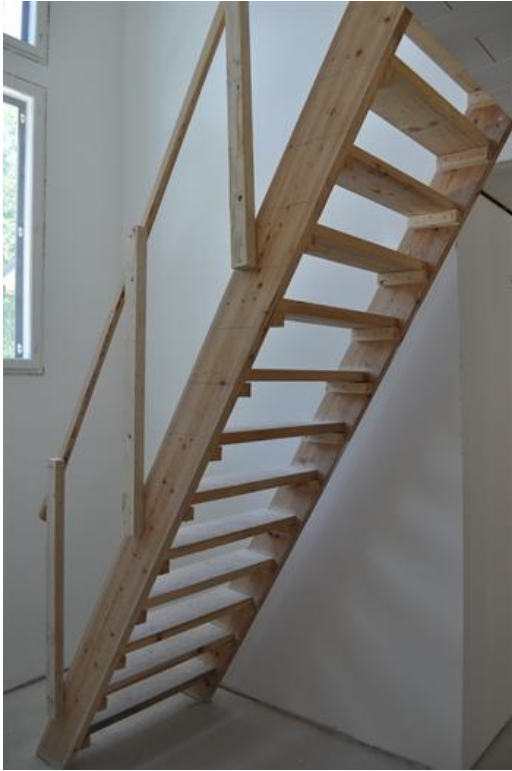
KUVA 4. Työmaa-aikaiset portaat (14)
