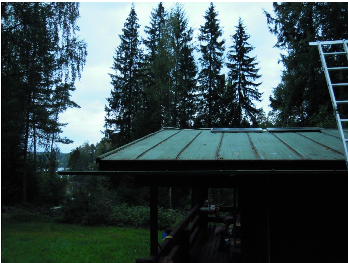
Kuva 9. Kaksi 90 W:n aurinkosähköpaneelia asennettuna katon harjalle
