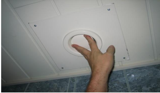
KUVA 9. Venttiilien kiinnilaitto
