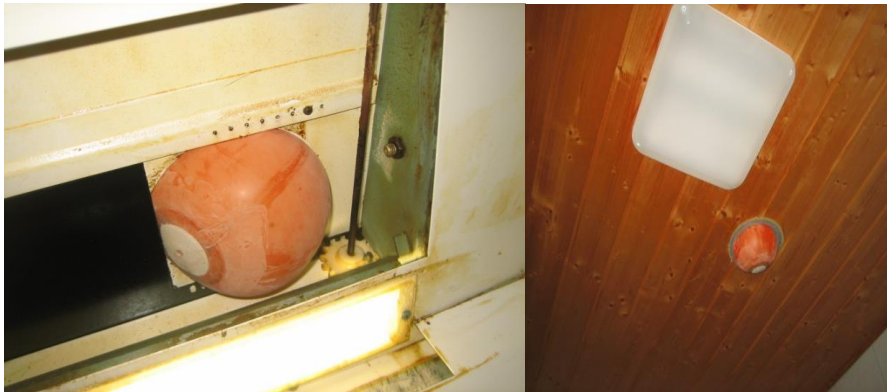
KUVA 11. Tiivistyspallo paikalleen asennettuna
