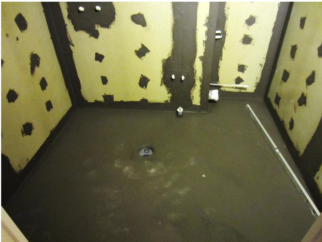
Kuva 3. Kaakeliluja-levytys ja vedeneristys
