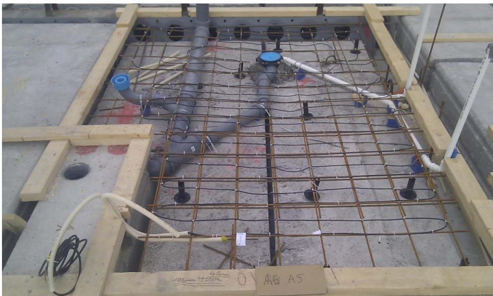
Kuva 2. Kaatolattian valmistelevat työt valmiina. (Kuva. Lauri Rihu).
