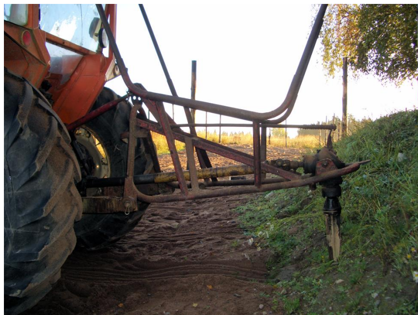
Kuva 15. Vanhanaikainen seiväskaira riitti tolppien pystyttämiseen etukuormaajatraktorin avustuksella.
