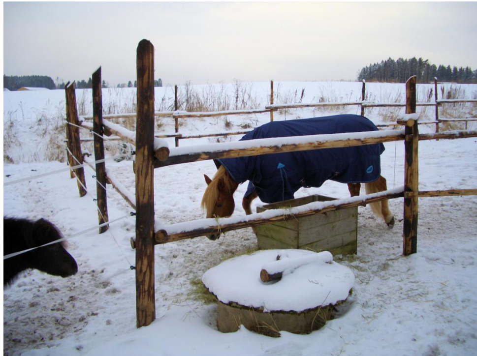
Kuva 13. Pystytolppien päät katkaistuna tasamittaan ja 45 asteen kulmaan.
