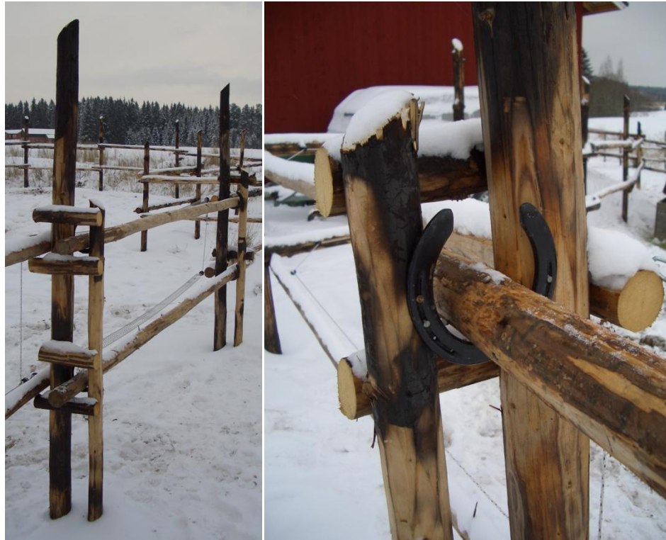
Kuva 25. Yksinkertainen porttiratkaisu: liikuteltava poikittaispuu. Hevoskenkä ei ole pakollinen, mutta hevosaitauksessa se käy koristeesta ja tekee liukkaudellaan puun liikuttamisen sujuvammaksi.
