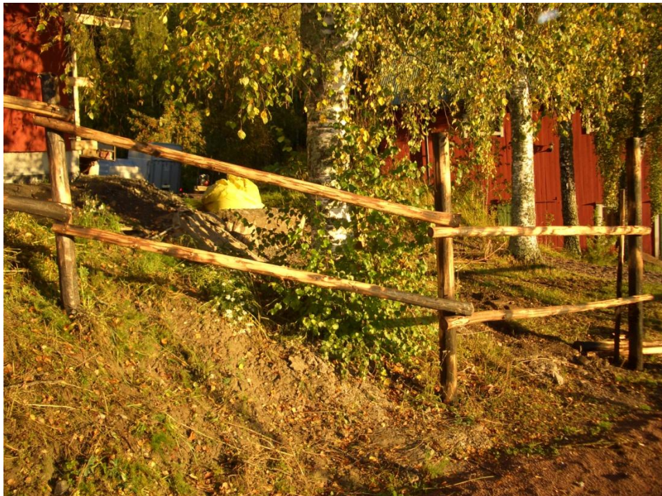
Kuva 23. Poikittaispuiden on oltava eläimen puolella kestävyuden vahvistamiseksi. Tässä kuvassa vaakaorsien korkeusvuorottelu ei jatku säännöllisesti johtuen pinnanmuodon vaatimasta erityishuomiosta.
