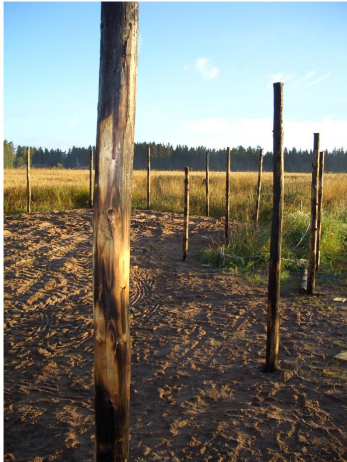
Kuva 22. Tolppien pystytys on haastavin osuus aidan rakentamisesta.
