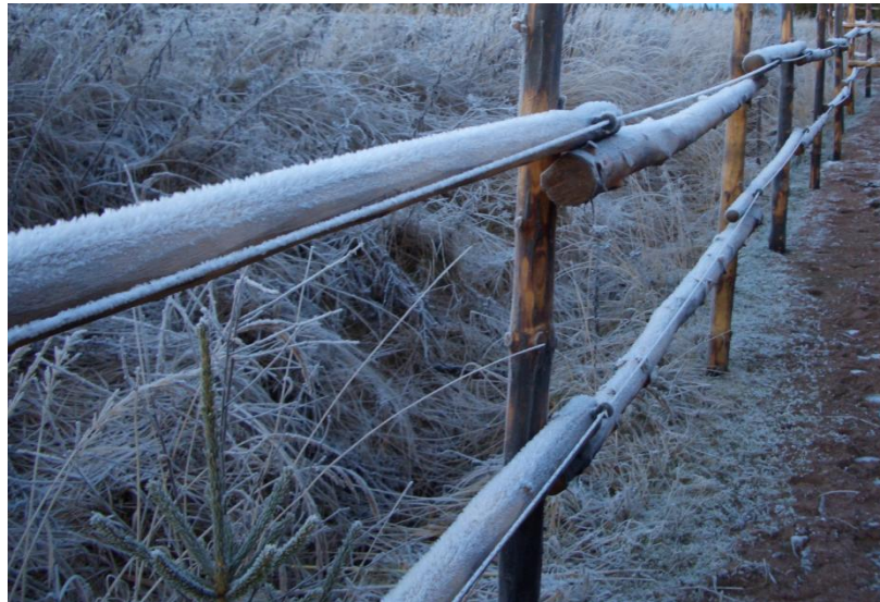
Kuva 26. Sähkölanka on hyvä lisäsuoja aidalle.
