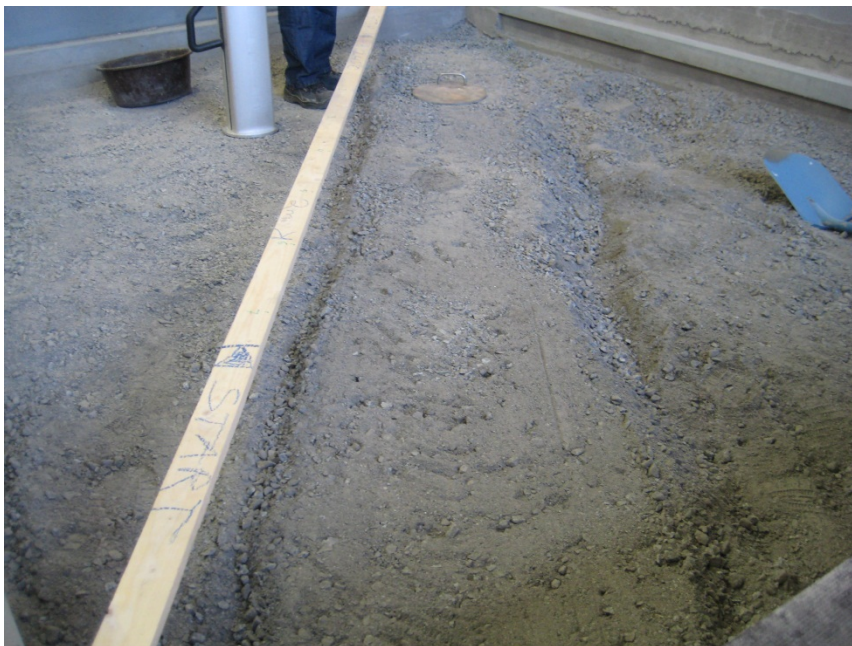
Kuva 8. Suora nostettu ajorata tiivistäminen tapahtui molempiin suuntiin ajaen (Kuva: Mikko Asunen 2012).
