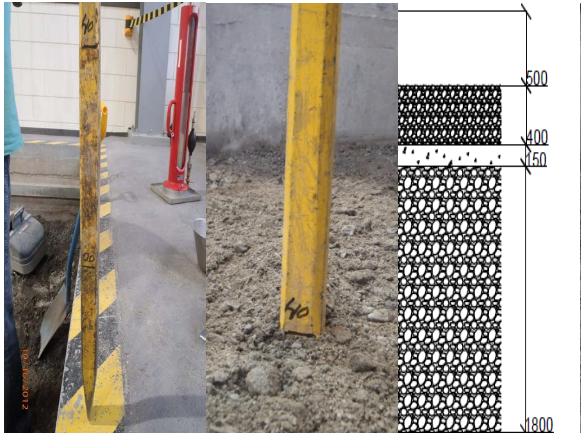
Kuva 18. Mittalaite ja havainne kuva testin rakennekerroksista (Kuva: Mikko Asunen 2012).
