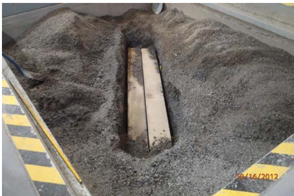
Kuva 14. Betonipalkit kaivannossa (Kuva: Mikko Asunen 2012).
