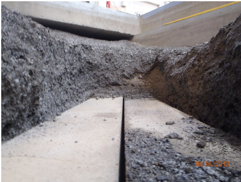
Kuva 15. Kuva betonipalkkien päältä ennen testin aloittamista (Kuva: Mikko Asunen 2012).
