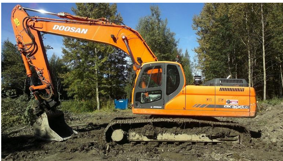
Kuva 1. Konevuokraamo Rentin 30 tonnia painava kaivukone työmaalla Helsingissä.
