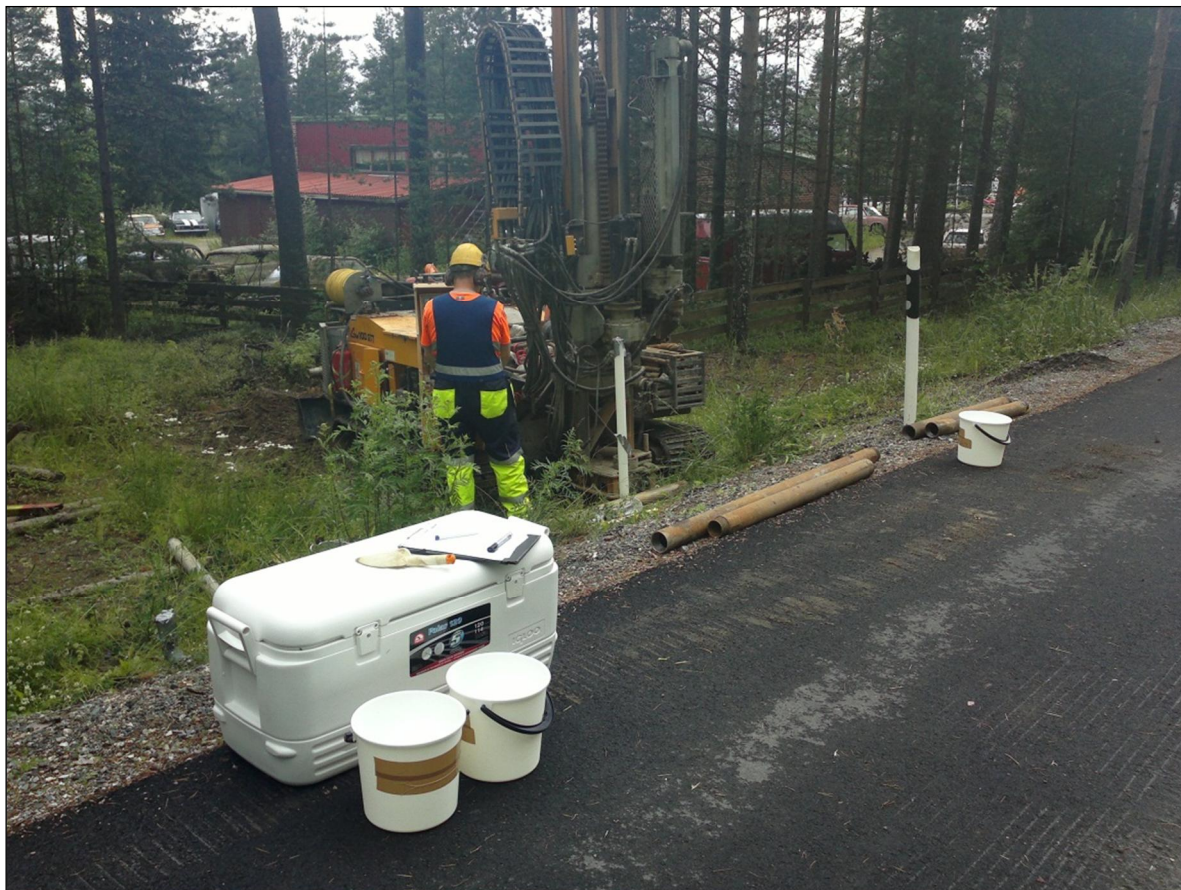
KUVA 7. Kairaustutkimukset ja maanäyte toteutettiin raskaalla maakairauskalustolla. Kuva Tervo 11.7.2012.
