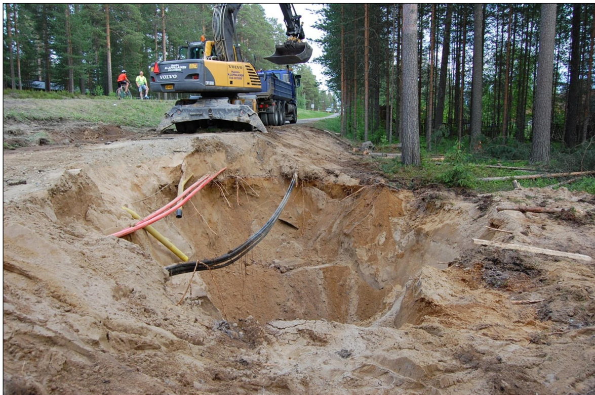
KUVA 3. Onnettomuuspaikan massanvaihtotöiden aikainen kaivanto ennen täyttöä. (Kuva Ari Ko- lehmäinen 2010)
