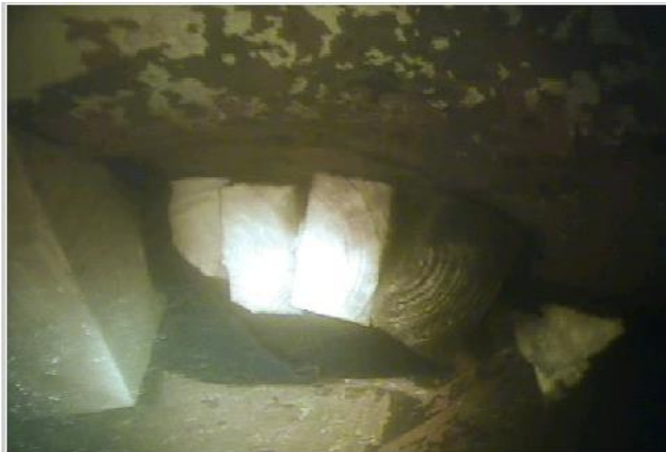
Kuva 11. Vaurion tilkkiminen puukiiloilla (Rannikon sukelluspalvelu Oy)
