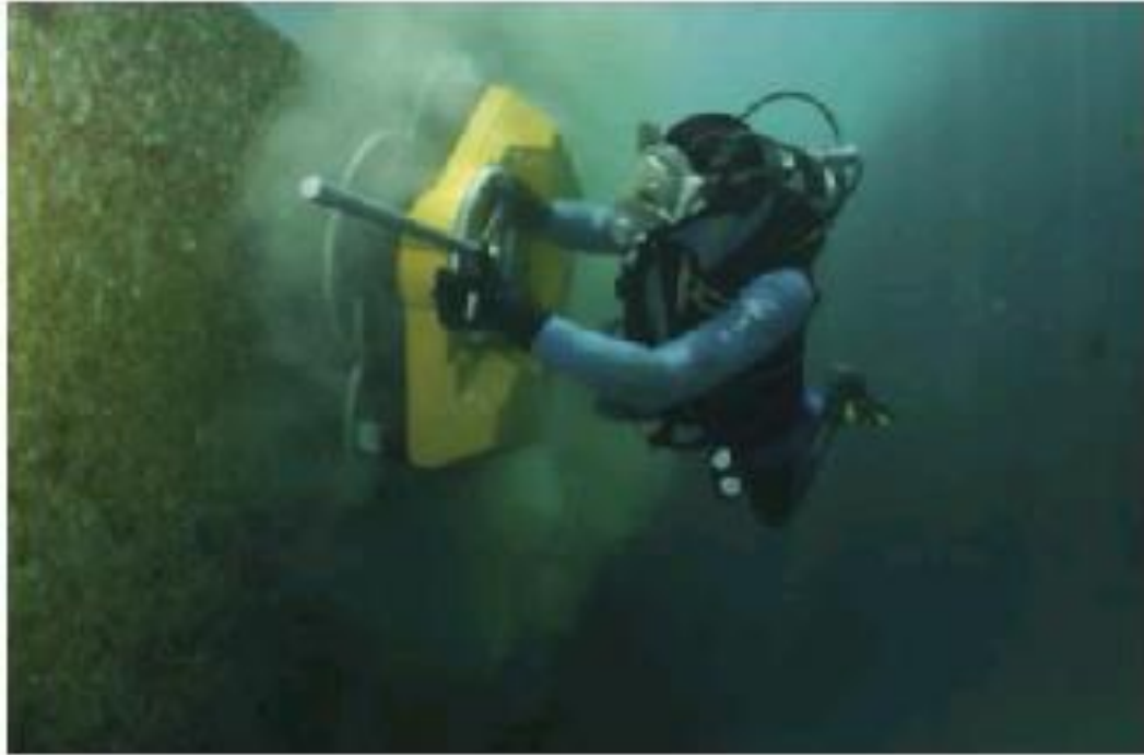
Kuva 3. Rungon puhdistusta ammattisukeltajan ohjaamalla harjakoneella (Armade-hull-verkkosivut)
