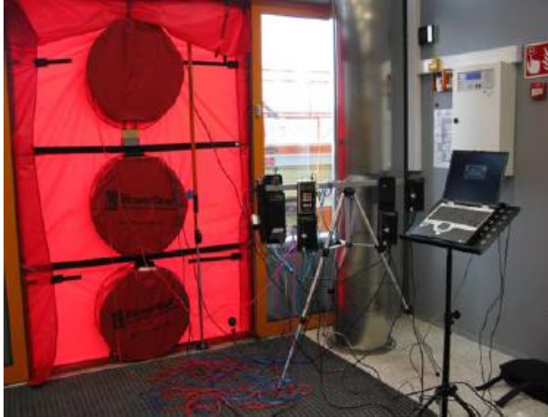
Kuva 3. Usean puhaltimen painekoelaitteistolla saadaan mitattua suurempienkin rakennusten ilmatiiveys. [15, s.15.]
