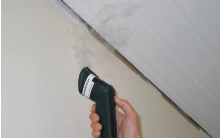
Kuva 6. Ylipainekesteessä vuotokohtia voi paikallistaa merkkisavun avulla. [11.]
