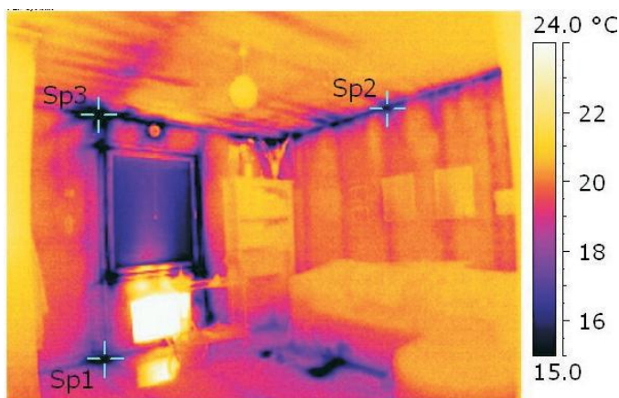
Kuva 5. Kuva otettu 50 Pa:n alipaineessa. [11.]
