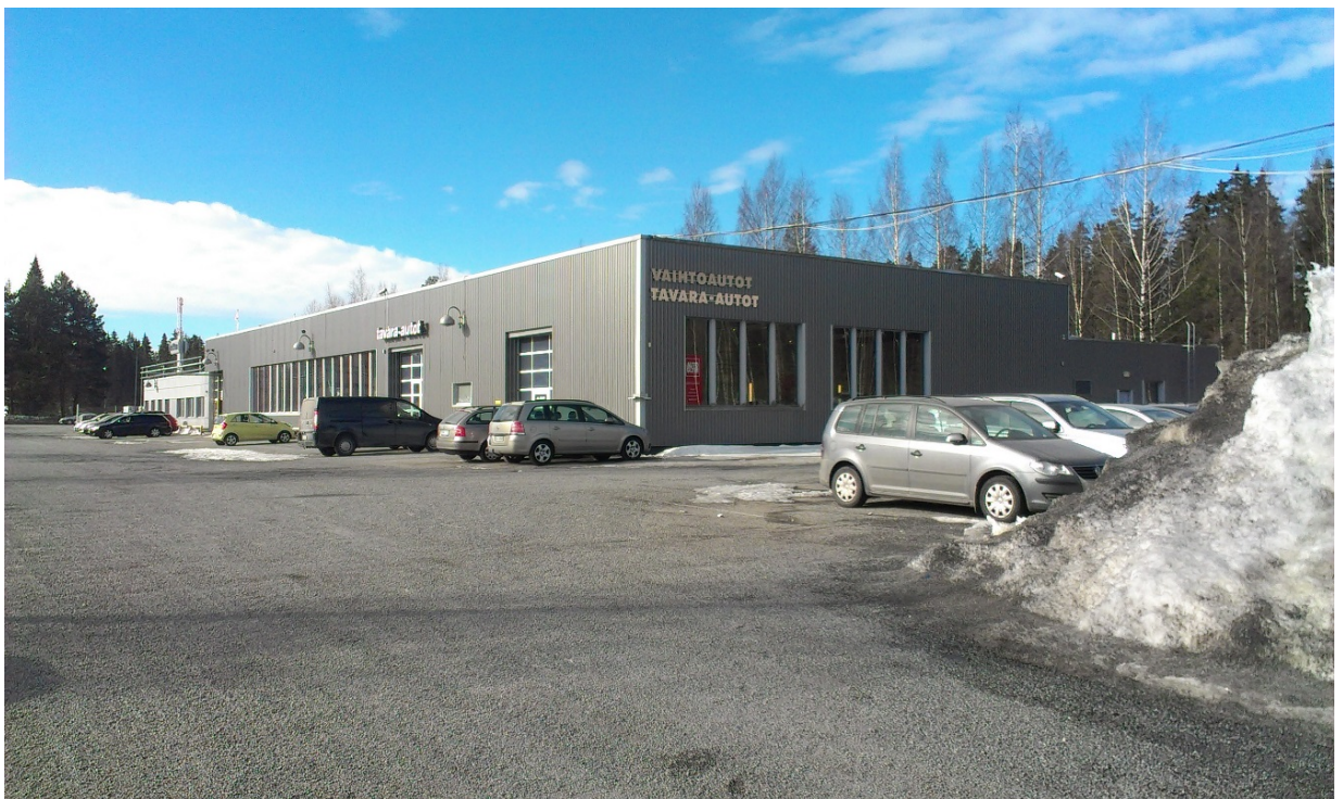
KUVA 2. Vanha rakennus, jonka päätyyn suunnitellaan autopesulaa
