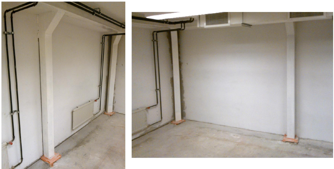
Kuva 12. Lisätyönä tehdyt välipohjalaatan pilarituennat alemmassa kellarikerroksessa.
