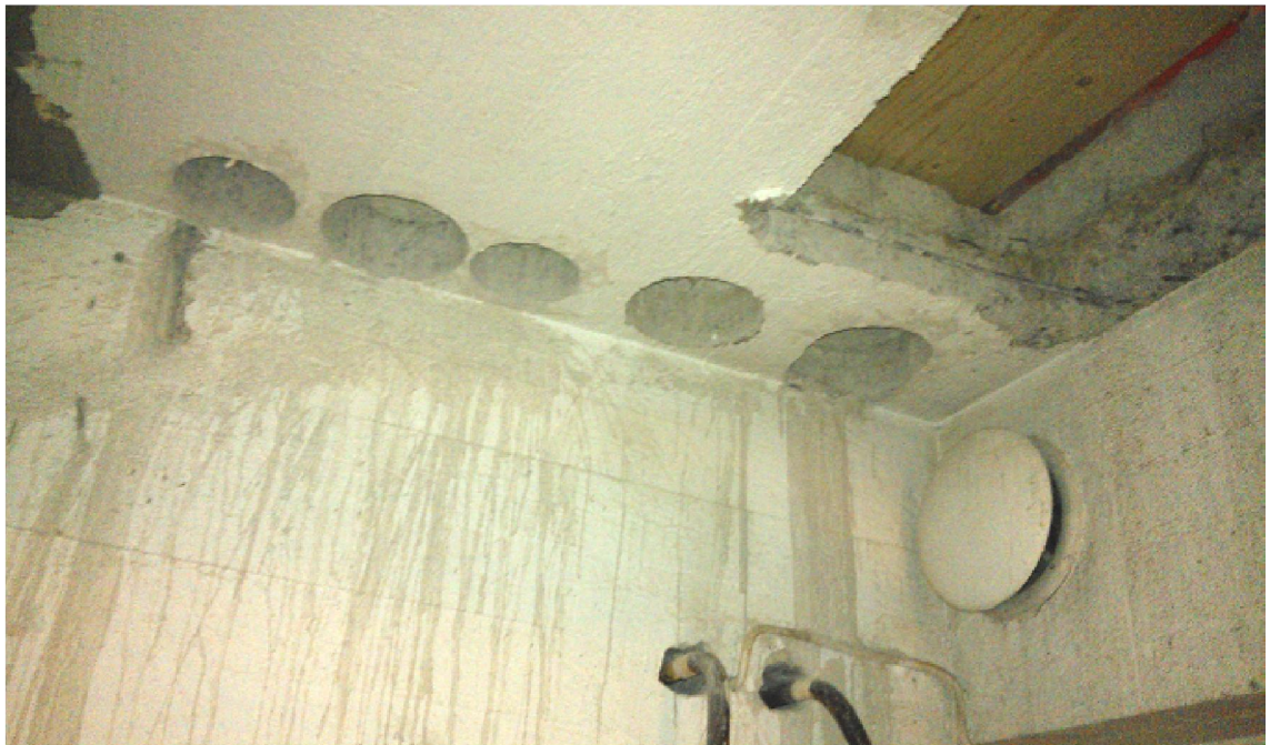
Kuva 7. Välipohjalaattaan tiheään porattuja uusia reikiä.
