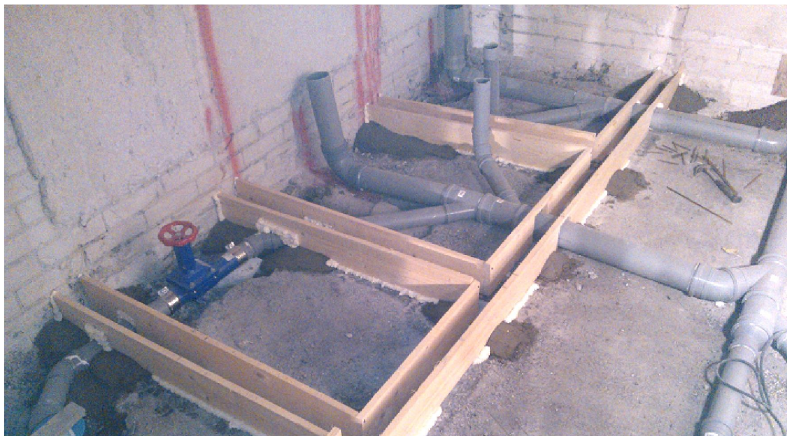
Kuva 10. Uudet pohjaviemärit on asennettu ja väliseinien pohjien valumuotit on rakennettu.
