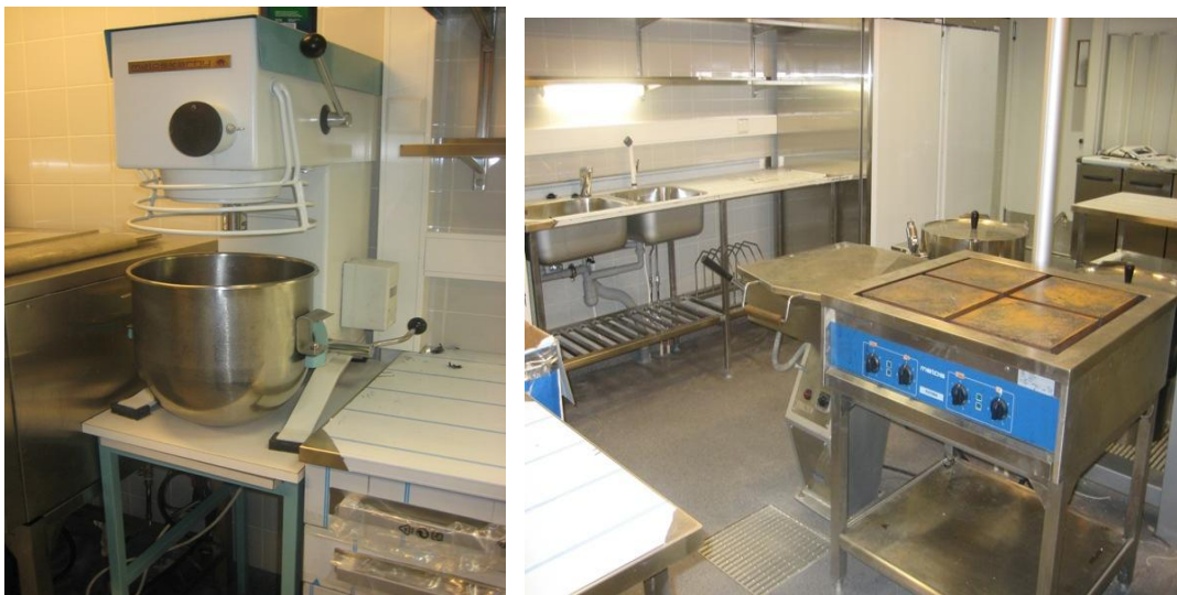
Kuva 9. Uusittuja vanhoja koneita.
