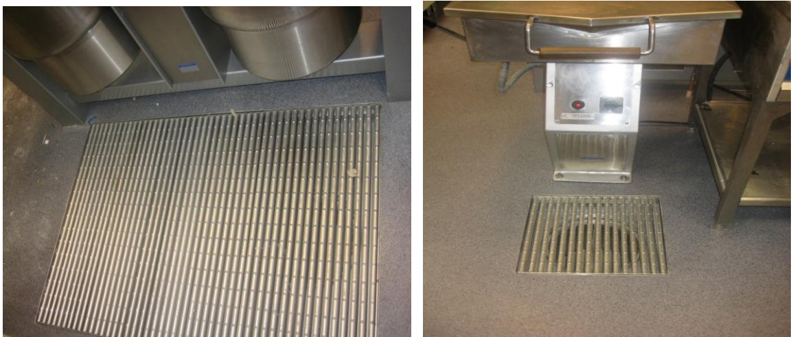
Kuva 8. Uusi lattia ja lattiakaivot.
