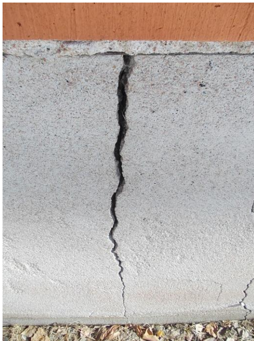
Kuva 23. Virvakodon sokkelin halkeama ja eteläpään murtunut tiilimuuraus. (Vuorinen 2013)
