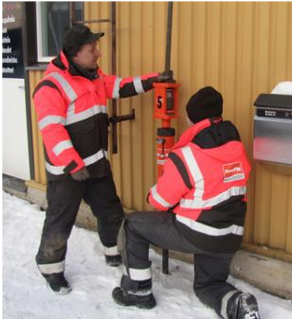
Kuva 17. Polymeeripilarin pieni asennuskalusto ja asennusjälki (PowerPile Oy 2012)
