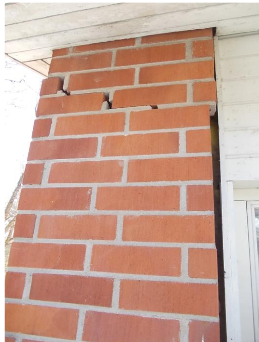
Kuva 23. Virvakodon sokkelin halkeama ja eteläpään murtunut tiilimuuraus. (Vuorinen 2013)
