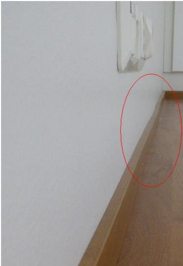
KUVA 6. Jalkalistan aaltoilu.
