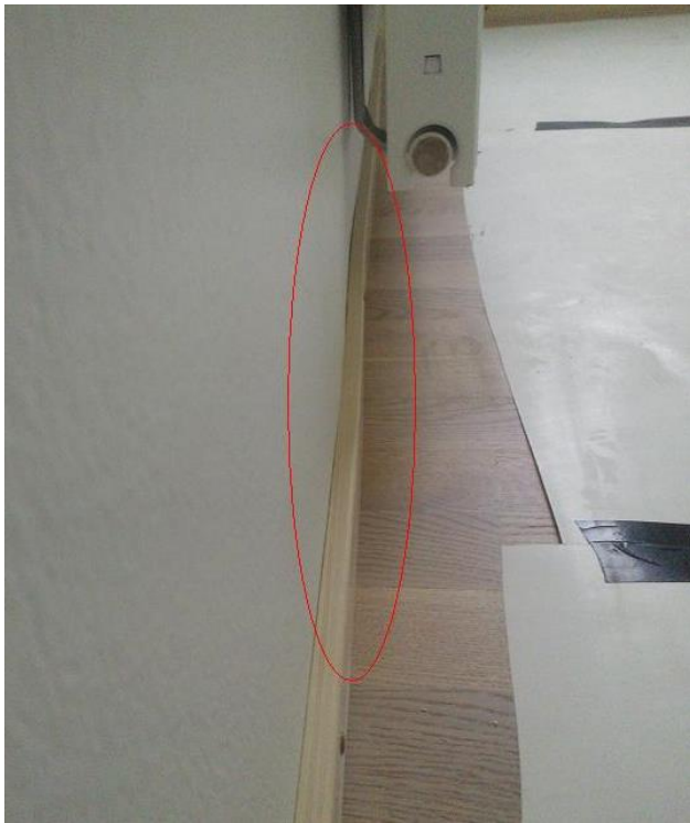
KUVA 8. Betoniseinän tasaisuuspoikkeama 1.
