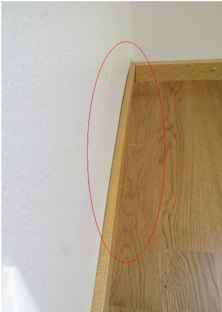
KUVA 11. Väliseinäelementin liitos ulkoseinäelementtiin 2.
