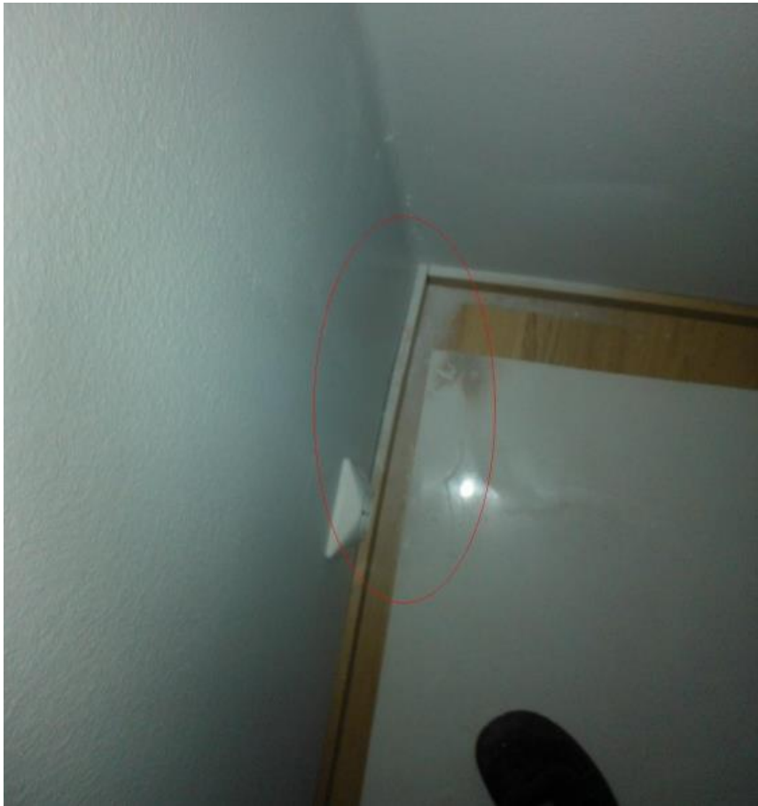
KUVA 10. Väliseinäelementin liitos ulkoseinäelementtiin 1.
