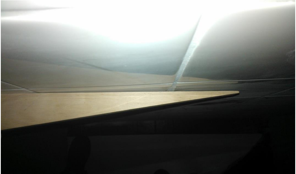
KUVA 13. Laattaseinän epätasaisuus.
