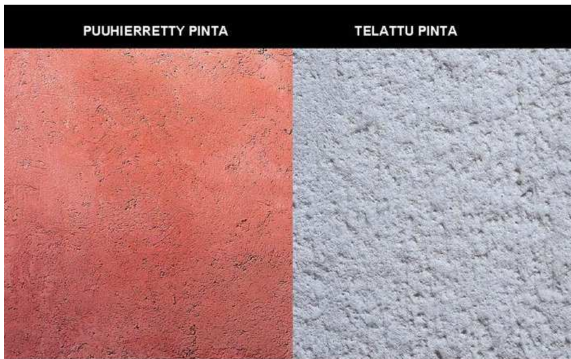
KUVA 2. Puuhierretty ja telattu betonipinta (Betonipinnat).
