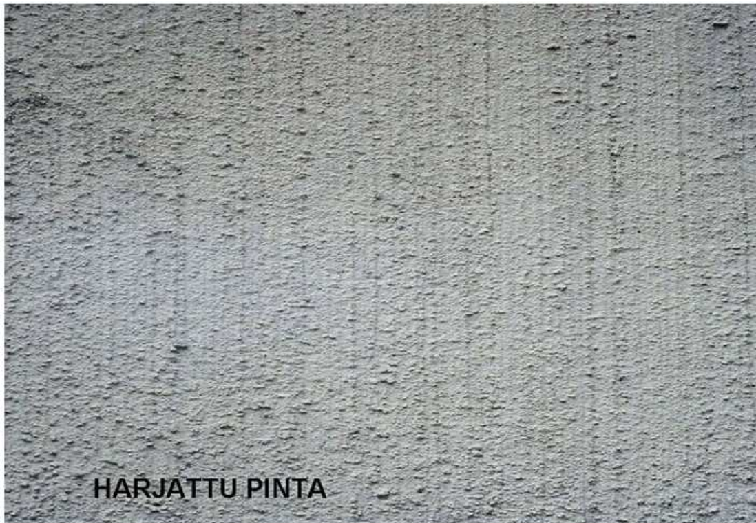
KUVA 1. Harjattu betonipinta (Betonipinnat).
