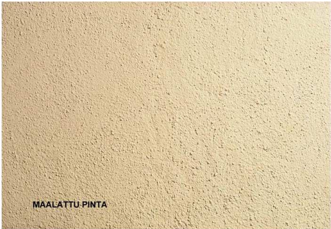
KUVA 5. Maalattu betonipinta (Betonipinnat).
