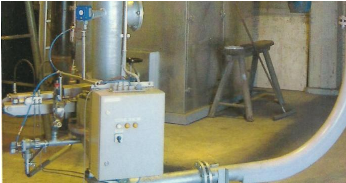
KUVA 3 Painekuljettimen kenttäkoteloon on kuljettimen tilaa kuvaavia valoja, sekä käynnistyskytkin. (Kopar[1])
