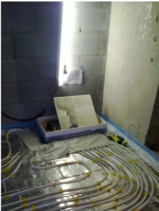
Kuva 19 Lattiamallinen, kalusteiden sokkeliin sijoitettava jakotukkikaappi. Kuva: Jere Viljanen
