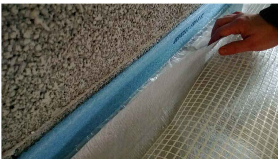
Kuva 22 Kuvassa näkyy lattiamassaa vaille valmis rakenne. Reunanauhan muovilieve käännetty erotuskankaan alle, jotta lattiamassa ei valu seinän ja levyjen väliin tai alle. Lasikuituverkko on levitetty erotuskankaan päälle. Kuva: Jere Viljanen
