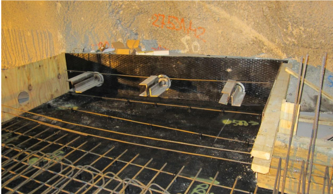
Kuva 19. Ankkurointiuloke ennen valua. Valulevy kiinnitettynä ankkurointiin. Bb (Liikennevirasto)
