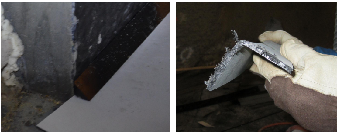
Kuva 22. Vasemmalla puolella on kolmiorima ja oikealla ulkokulma. (Liikennevirasto / Pöyry Finland Oy)
