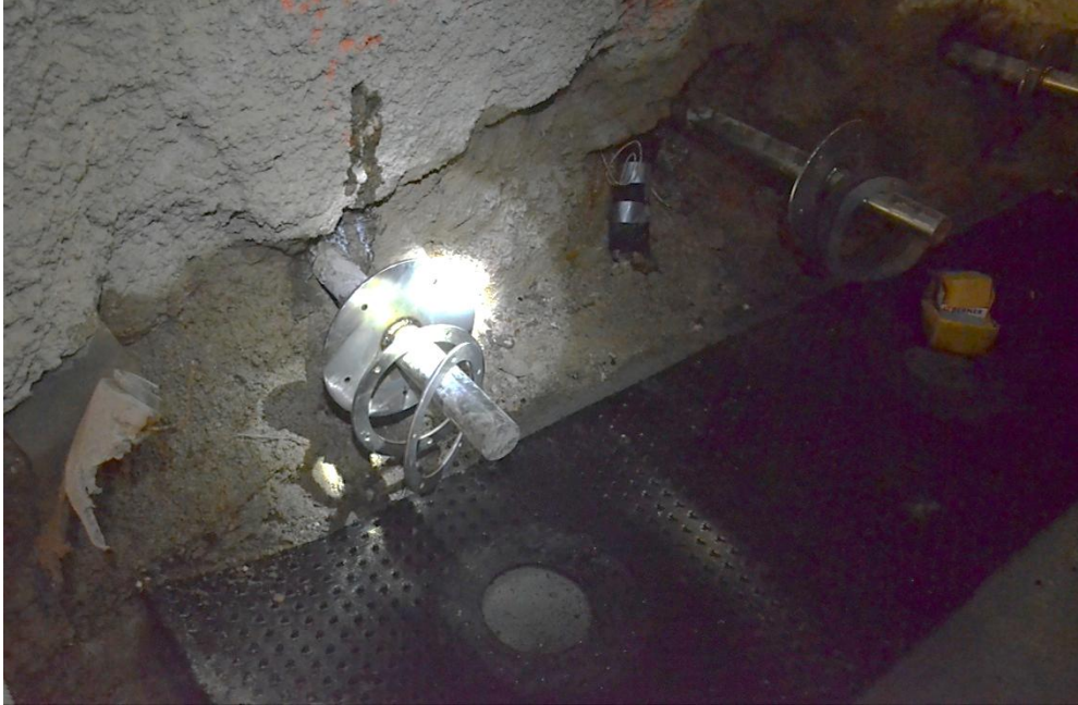
Kuva 26. HST-peltilaippa hitsattuna ankkurointitappiin. (Liikennevirasto)
