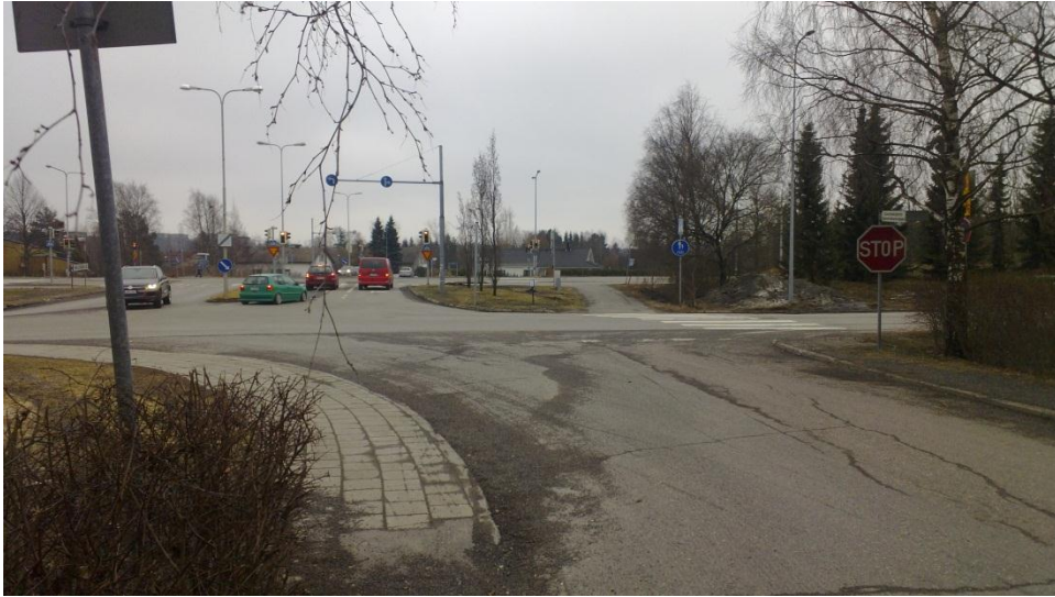
Kuva 39. Uunintekijäntien, Viilarinkadun ja Lasimestarintien risteys
