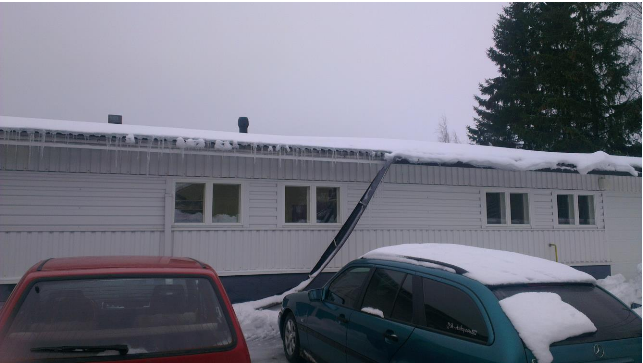
Kuva 1. Kohteen lämpövuodon ilmeneminen
