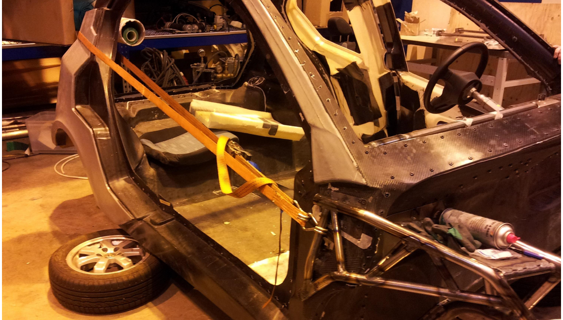
Kuva 12. Eturungon asennus ja asennuksessa käytetty apulaite
